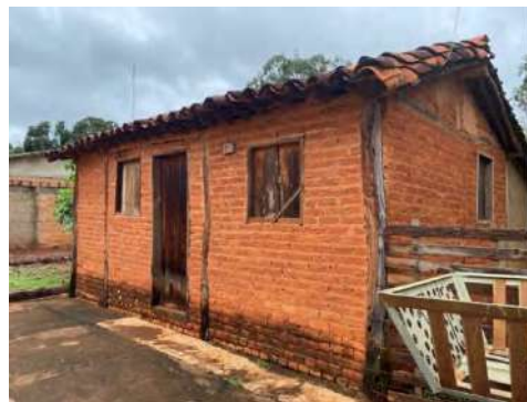
Foto 38 Imagem com destaque para fachada frontal e vista parcial da fachada lateral direita. Foto: por Catherine H. Salgarello.
