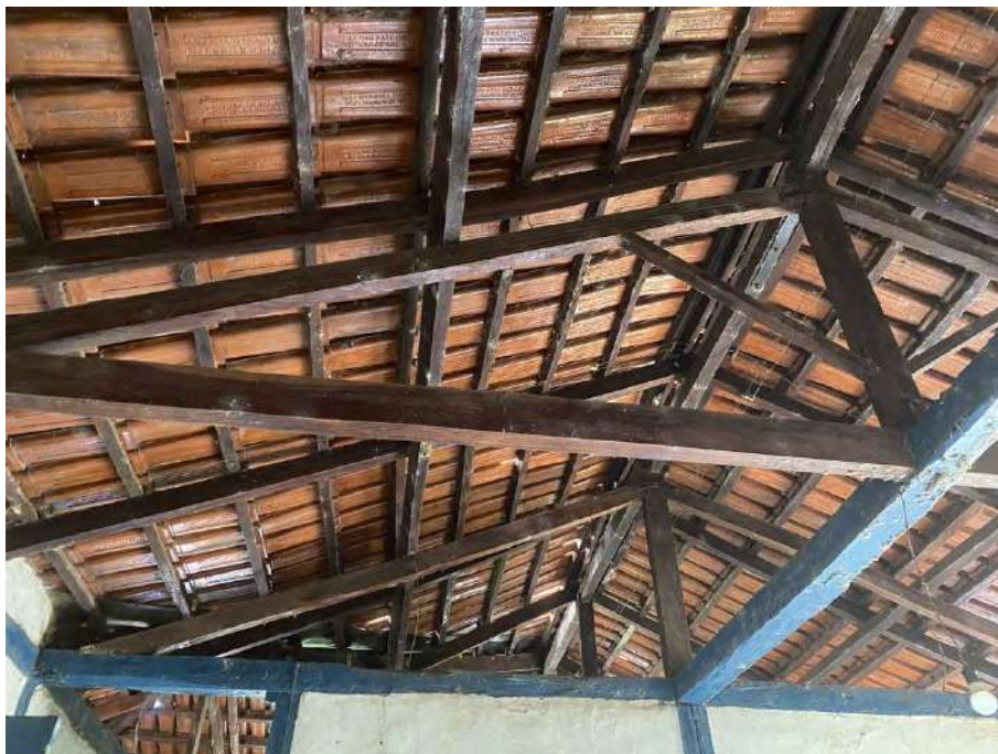
Foto 130 Telhado aparente. Engradamento recente com peças em ótimo estado de conservação.
