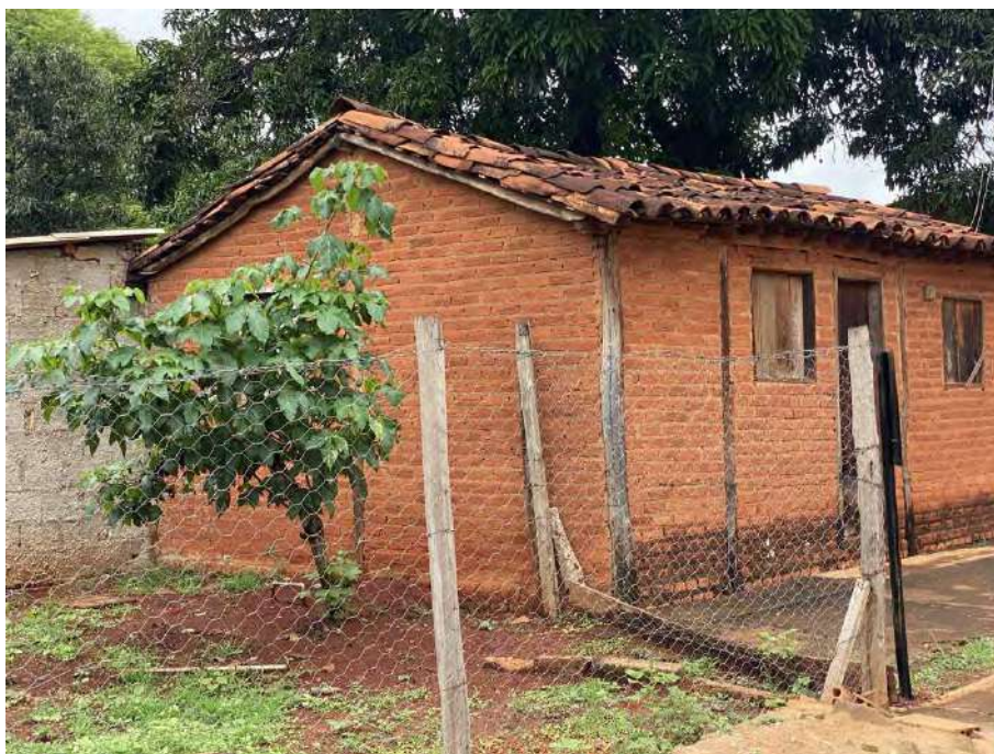
Foto 43 Lateral esquerda. Detalhe para os tijolos maciços a vista.
