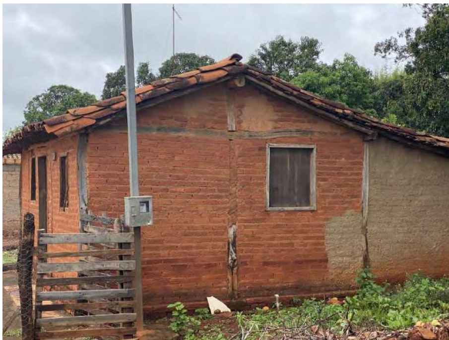
Foto 42 Detalhe da fachada lateral direita. Estrutura independente de madeira em evidência.
