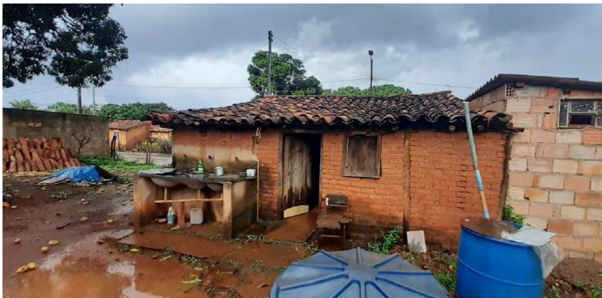
Foto 44 Fachada posterior. Detalhe para o volume de tijolos cerâmicos quântico à edificação original.
