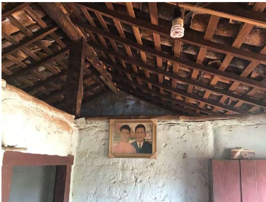
Foto 33 Estrutura e engradamento do telhado à mostra a partir da sala da residência.
