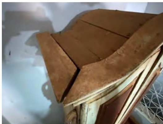
Foto 150 Na primeira foto vista da porção superior do Oratório do Altar-Mor e na segunda foto detalhe para partes soltas, com pequenas perdas de material, descolamento da camada pictórica e sujidades aderidas. Foto: Catherine H. Salgarello. Data: novembro de 2021.
