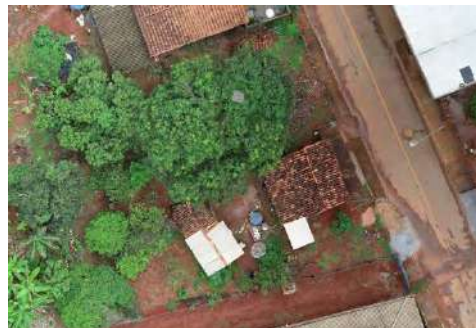
Foto 37 Implantação do imóvel-Imagem RPA por Henrique Piló
