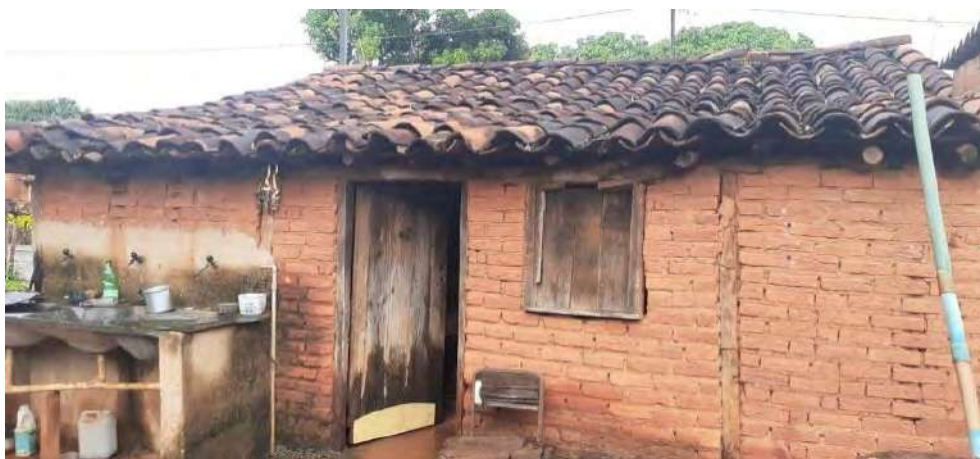
Foto 53 Detalhe da porta e janela da fachada de fundos da residência. Observa-se perda de material, com emenda na porção inferior da porta, manchas de umidade ascendente e ressecamento generalizado da madeira
