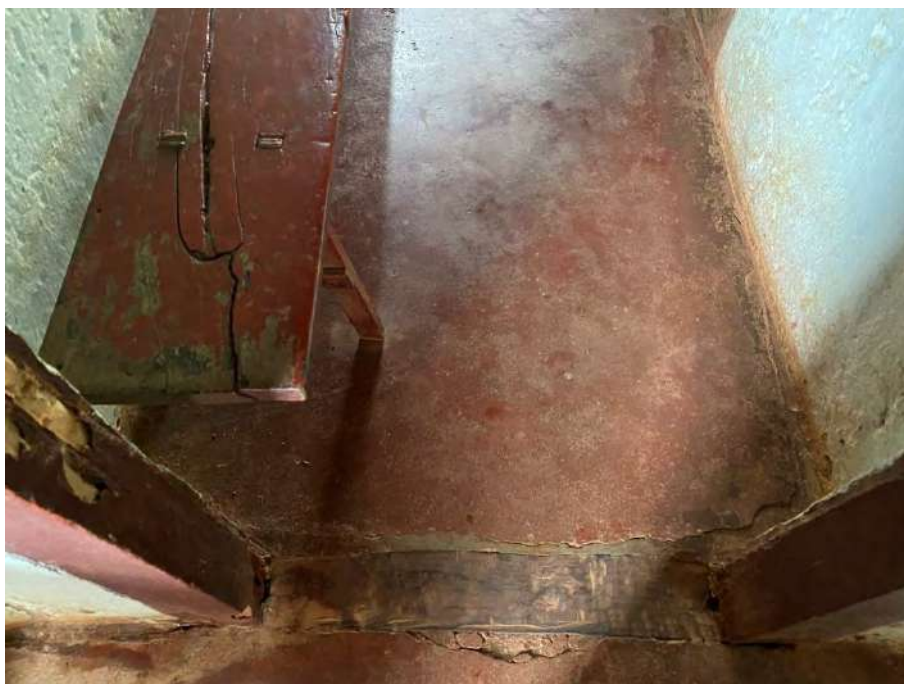
Foto 34 . Detalhe para piso em cimento queimado, que caracteriza a maior parte da residência. O trecho mostra a circulação, a partir da sala do imóvel
