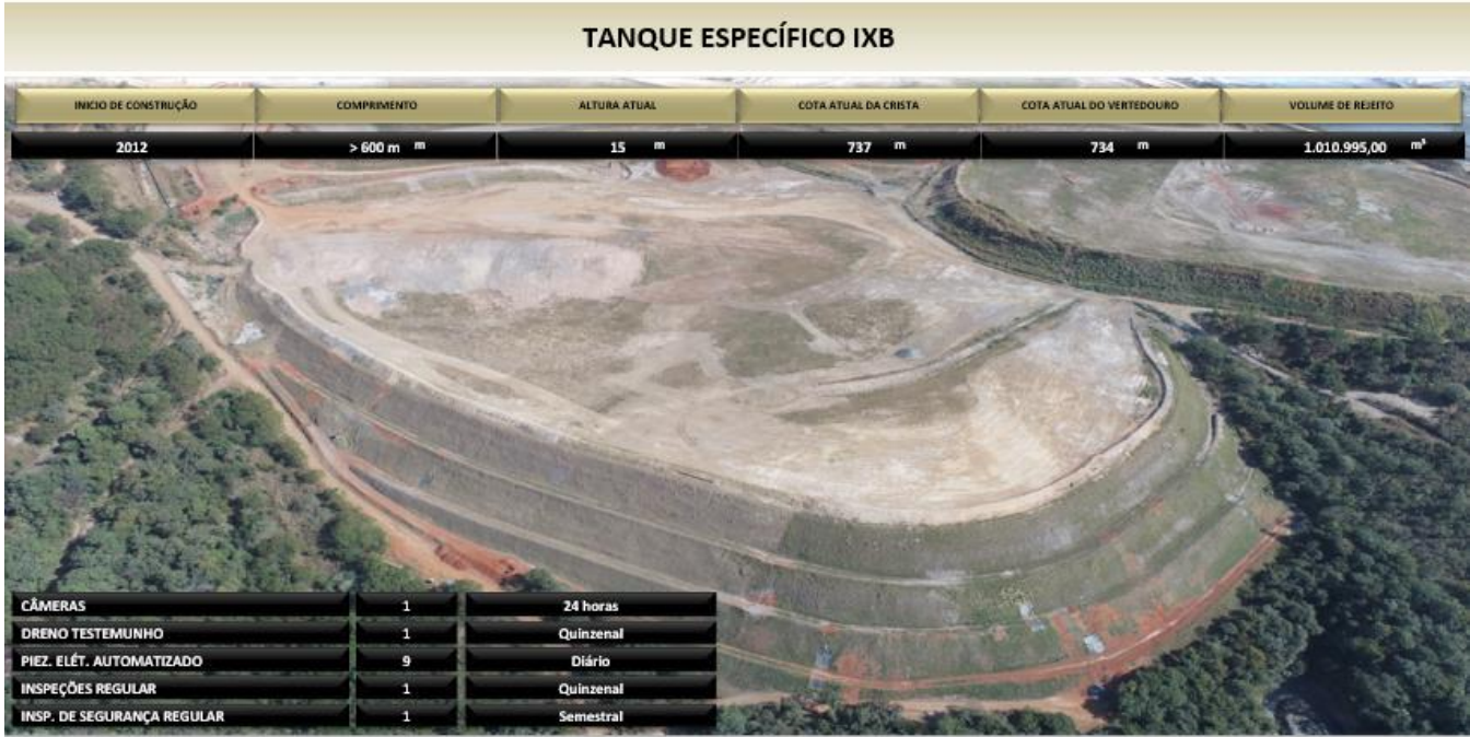
Figura 8 - Monitoramento e Instrumentação Tanque Específico IX-B
