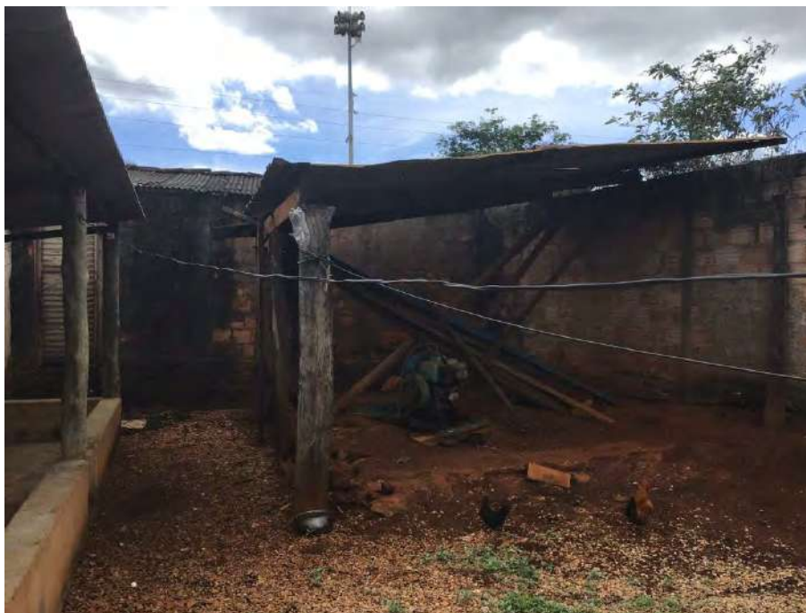
Foto 25 Anexo cobertura de fibrocimento apoiado em estrutura de madeira apoiada diretamente no solo e no muro de divisa nos fundos do lote. Destaque para porta em alumínio com acabamento do tipo veneziana, instalado no muro de divisa.
