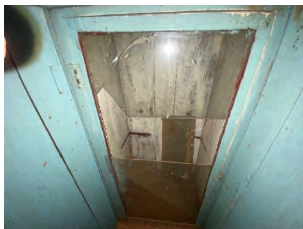
Foto 167 Na primeira foto vista superior do Oratório sem uso aparente com perdas de material, descolamento da camada de pintura e sujidades aderidas e na segunda foto detalhe da parte interna do Oratório com os vidros quebrados, descolamento da camada de pintura e sujidades aderidas Foto: Catherine H. Salgarello. Data: novembro de 2021.
