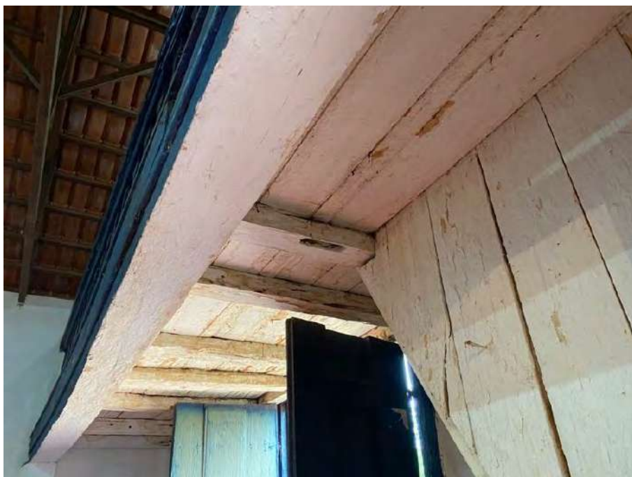
Foto 104 Vista inferior da estrutura que sustenta o tabuado do coro e fechamento em madeira da escada de acesso.
