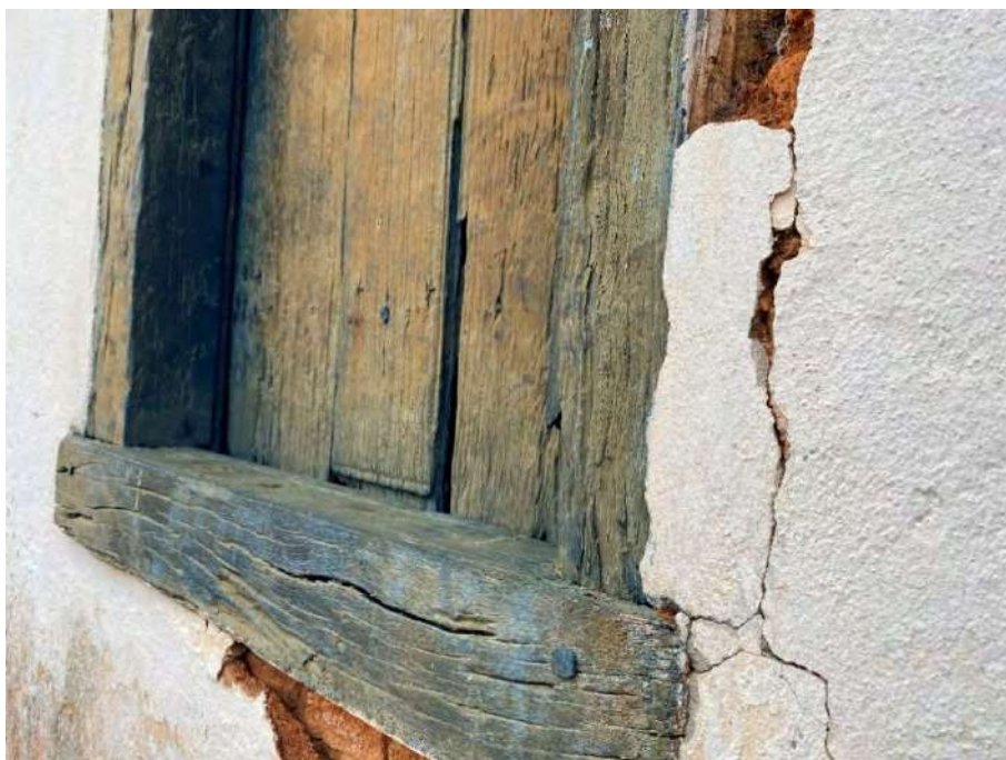
Foto 94 Detalhe para esquadria externa e estado de conservação da madeira com pintura esmaecida e ressecamento generalizado. Na alvenaria, perdas e manchas da camada superficial da pintura além de perda do reboco, deixando a alvenaria à mostra.
