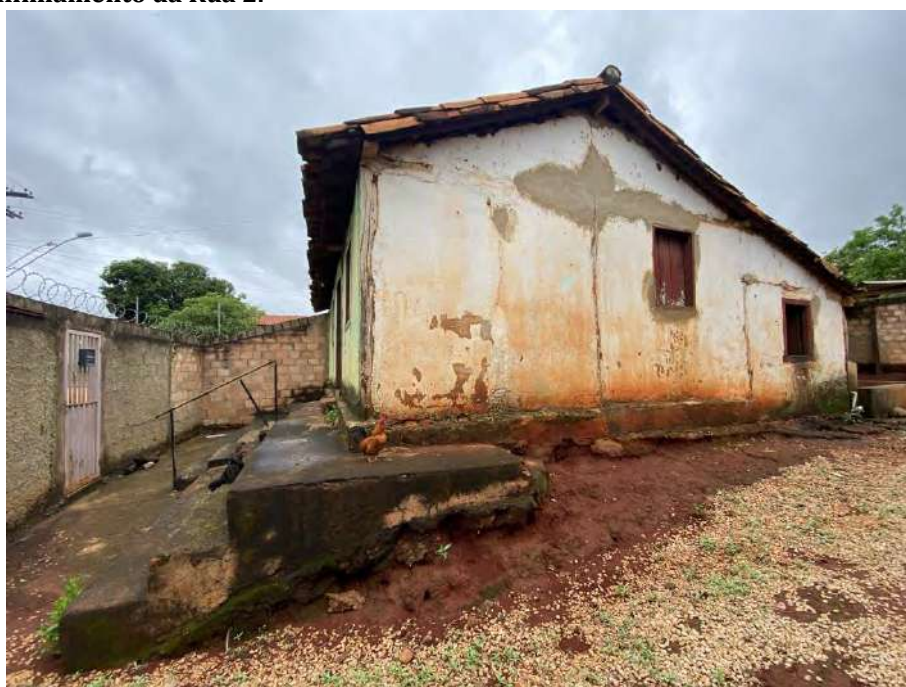
Foto 22 Vista embasamento em alvenaria para acesso ao interior do imóvel. Em destaque, fachada lateral direita da construção
