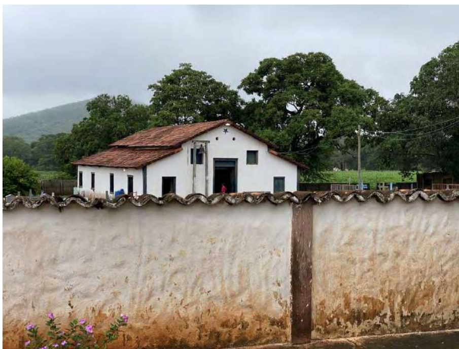
Foto 113 Detalhe do fechamento frontal do terreno, com muro de alvenaria e acabamento em telha.
