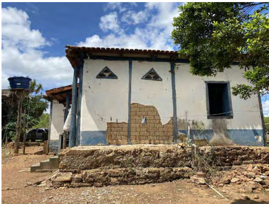
Foto 121 Fachada posterior. Destaque para os adobes a vista.
