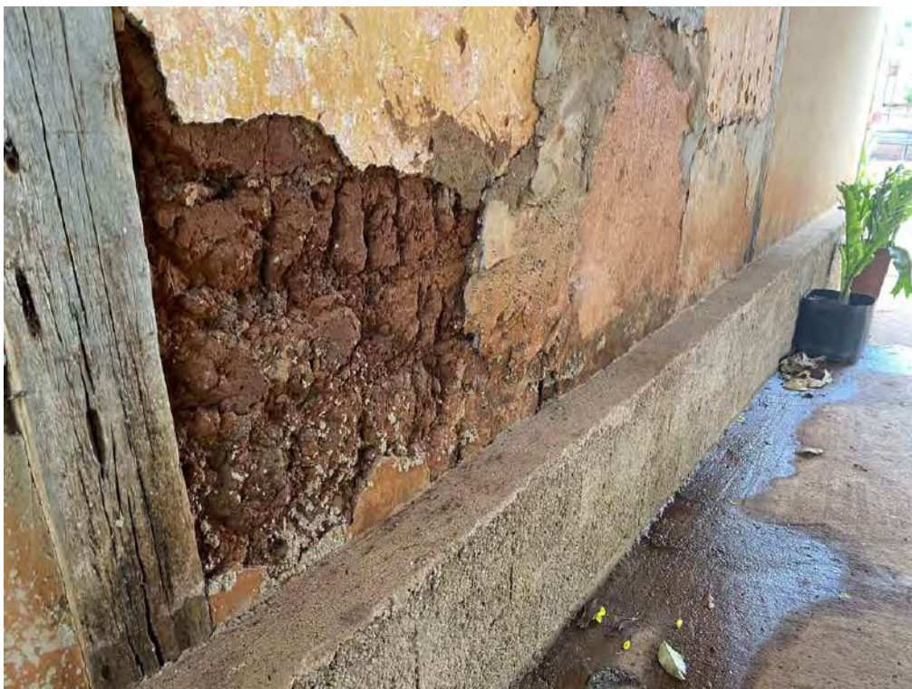
Foto 72 Desprendimento do reboco da garagem deixando o adobe aparente
