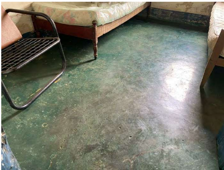
Foto 129 Piso de cimento queimado do interior da casa sede.
