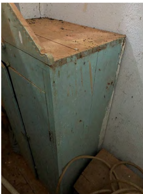
Foto 168 Vista da parte frontal e da lateral direita do Oratório, que apresenta perdas de material, descolamento da camada de pintura e fissuras na madeira. Foto: Catherine H. Salgarello. Data: novembro de 2021.
