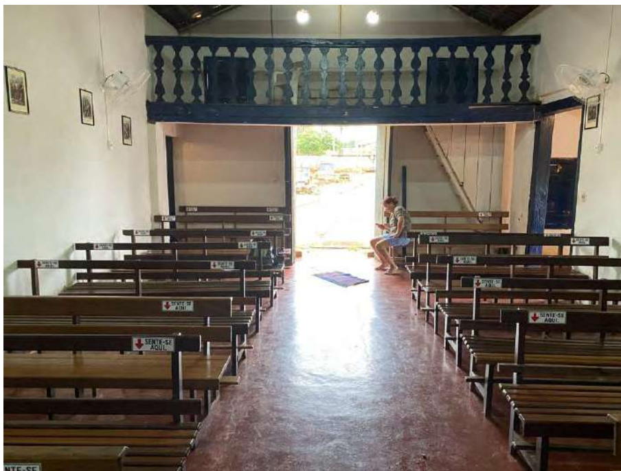
Foto 97 Vista da nave com piso em cimento queimado, a partir do altar
