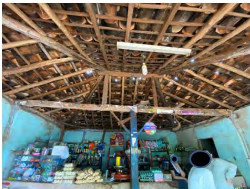
Foto 60 Vista geral do interior do bar, com estrutura do telhado, engradamento e telhas à vista
