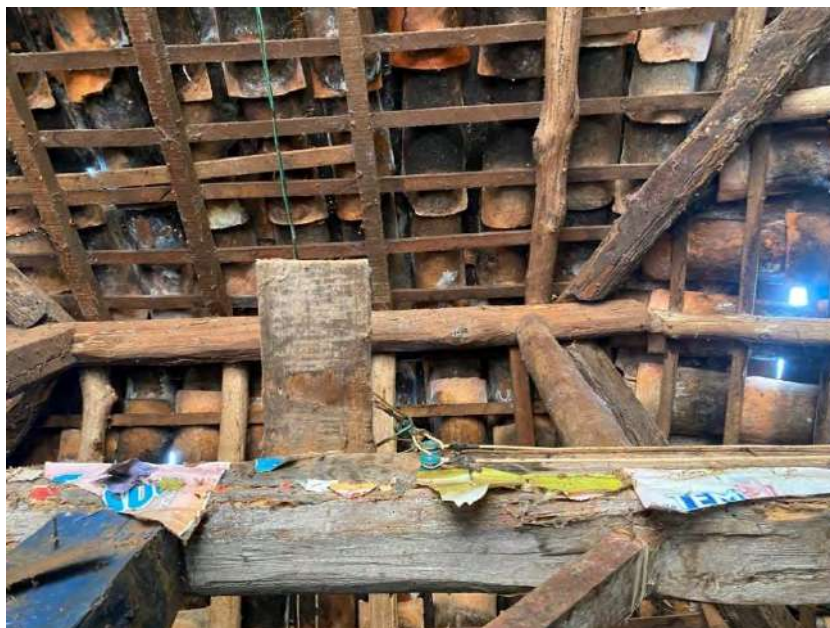
Foto 61 Detalhe porção superior do pilar em madeira, estrutura do telhado, engradamento e telhas (deslocadas) no interior do bar
