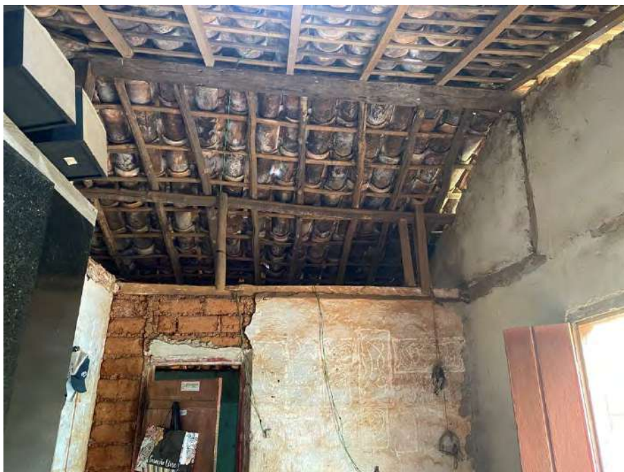
Foto 85 Vista parcial da parede entre o quarto 01 e o corredor. Detalhe para a parede de adobe. À direita, janela da fachada frontal
