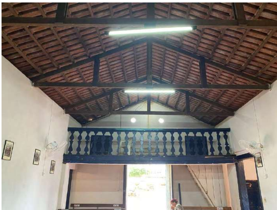
Foto 98 Vista da nave e detalhe para coro e cobertura com estrutura do telhado, engradamento e telhas aparente
