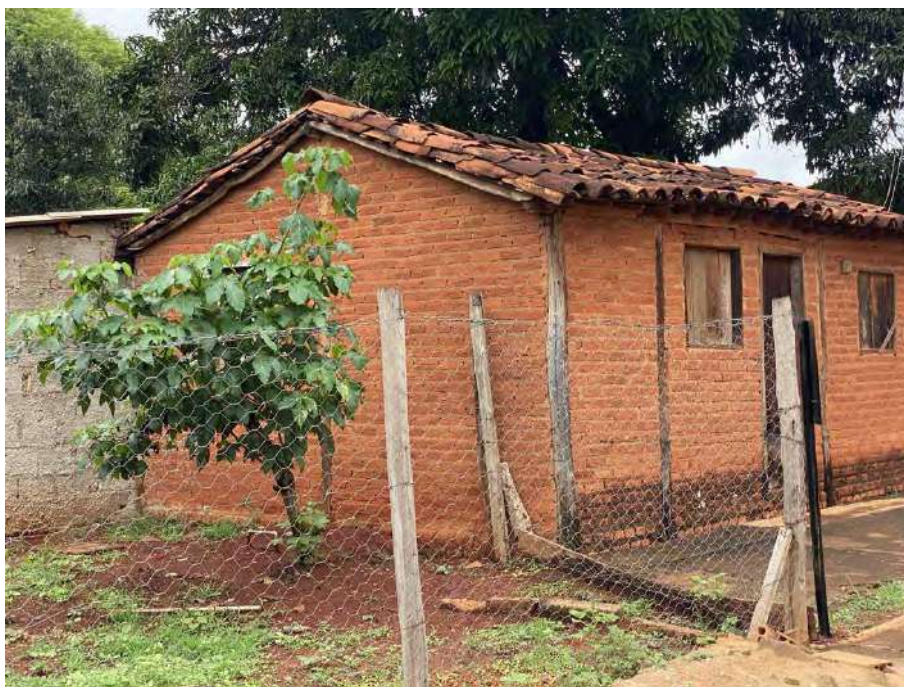
Foto 43 Lateral esquerda. Detalhe para os tijolos maciços a vista.
