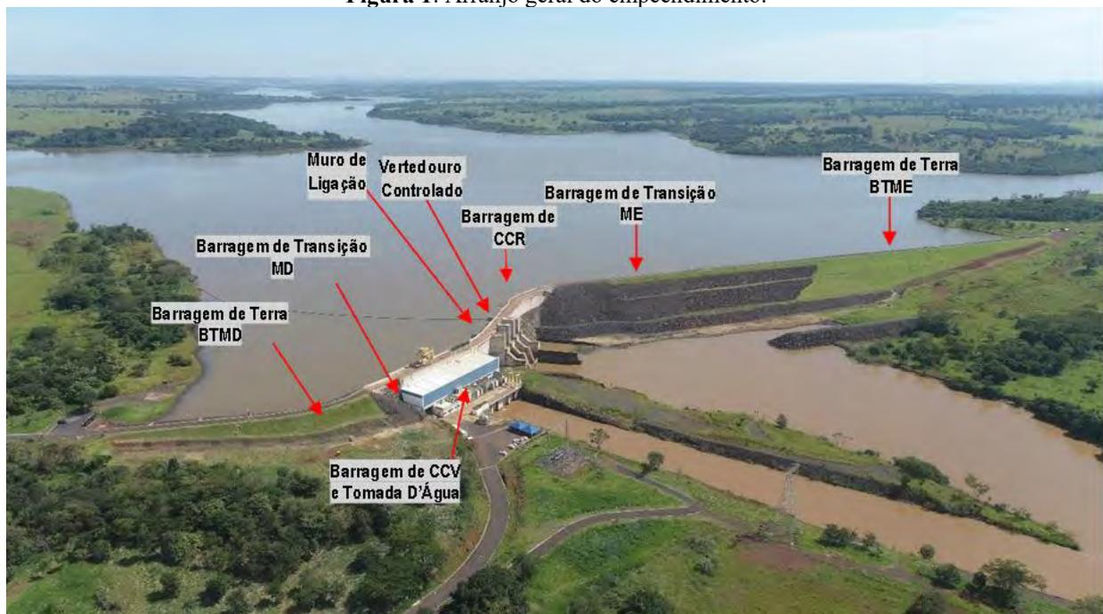
A Barragem Caçu possui dois tipos de estruturas de barragem, barragens de terra e enrocamento nas margens e estruturas de concreto (barragem de concreto, casa de força e vertedouro) na região central. O Quadro 1 e 2 resume as características básicas de cada uma das estruturas.
