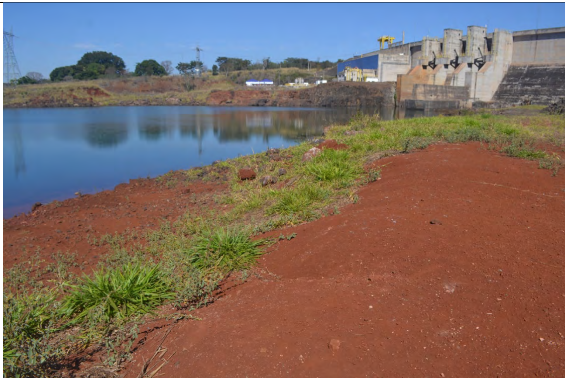
FOTO 66. MARGENS A JUSANTE DA BARRAGEM.
