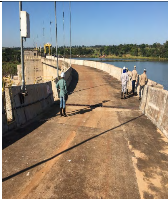
FOTO 58. CRISTA DA BARRAGEM DA MARGEM ESQUERDA – SEM SINAIS DE COMPROMETIMENTO ESTRUTURAL.
