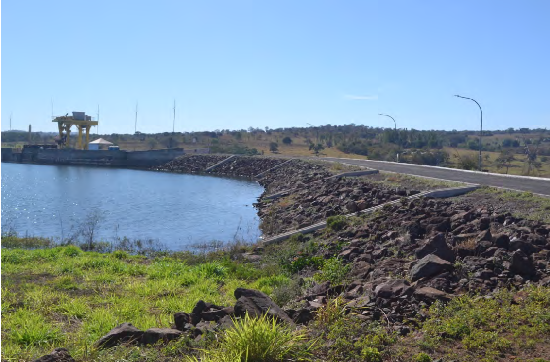
FOTO 1. BARRAGEM MARGEM DIREITA MONTANTE.
