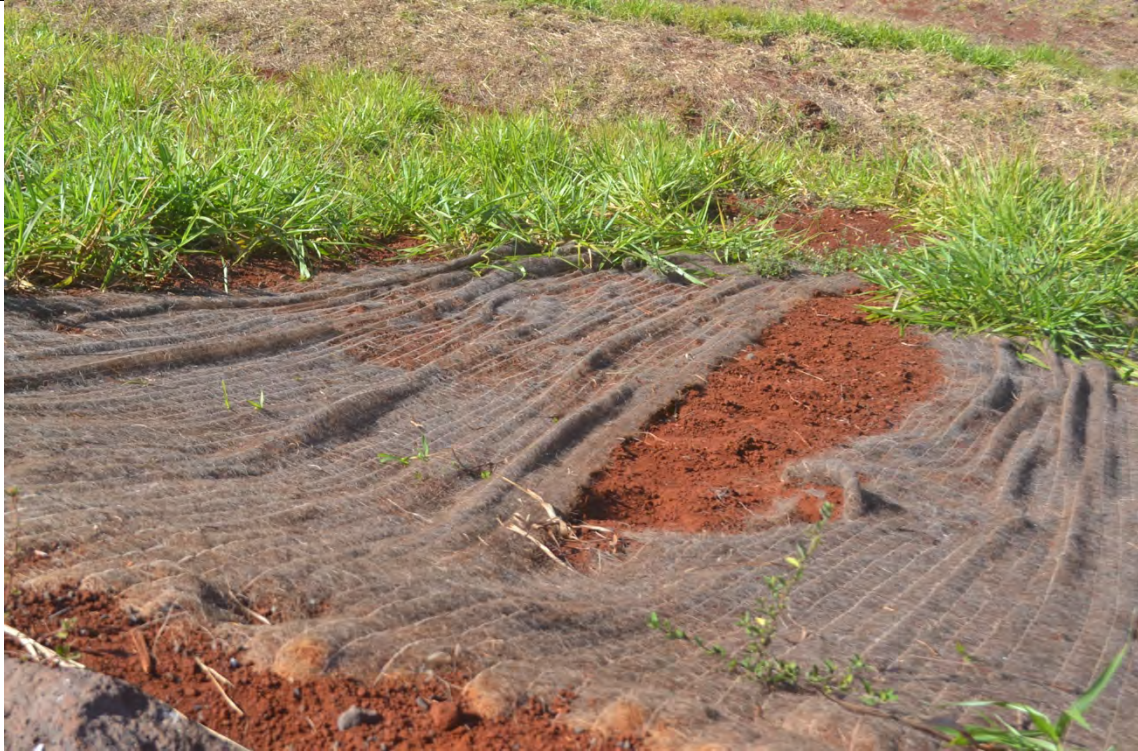
FOTO 54. REGIÃO EM RECUPERAÇÃO COM BIOMANTA.
