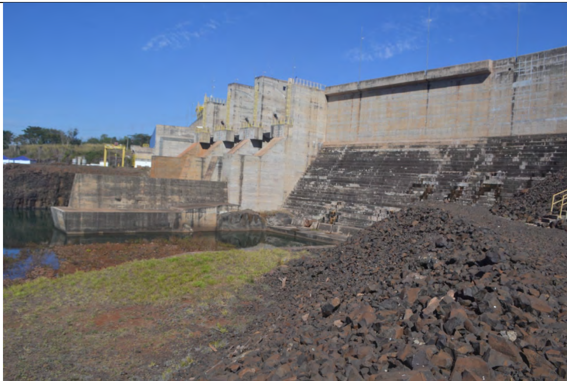
FOTO 46. REGIÃO A JUSANTE DA BARRAGEM DE CCR.
