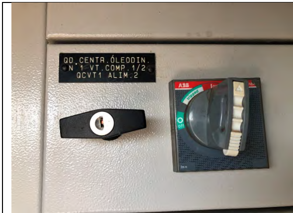
QDVT – Gaveta para alimentação AC 2 da central hidráulica 1 – Tag aparentemente errado
