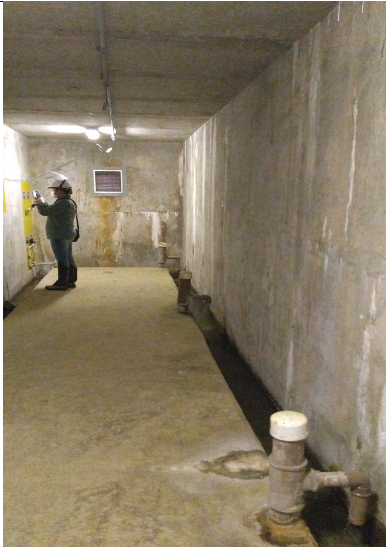
FOTO 74. GALERIA DE DRENAGEM. VISTA GERAL.
