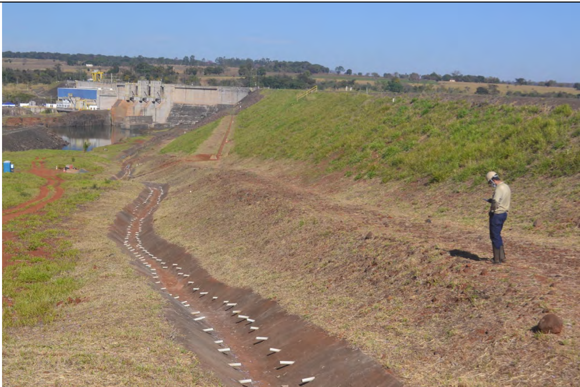
FOTO 55. INICIO DA CANALETA, VISTA PARA JUSANTE.
