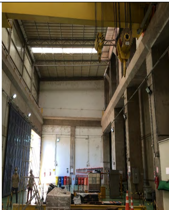
FOTO 4. ÁREA DE MONTAGEM – PILARES E VIGAS DA PONTE ROLANTE - SEM SINAIS DE QUALQUER COMPROMETIMENTO ESTRUTURAL.
