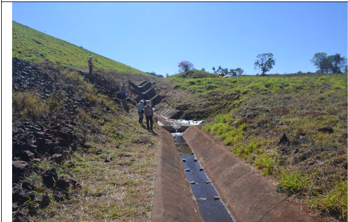
FOTO 63. CANALETA DE DRENAGEM.
