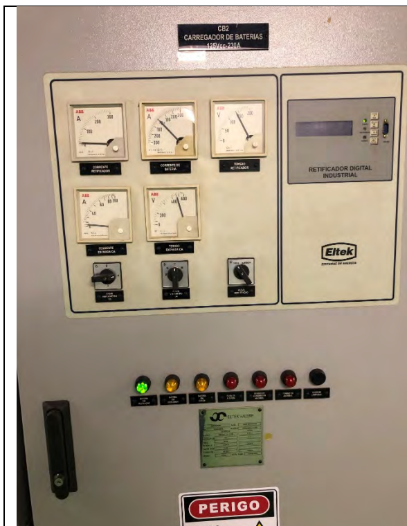
Carregador de Baterias 2 – Normal
