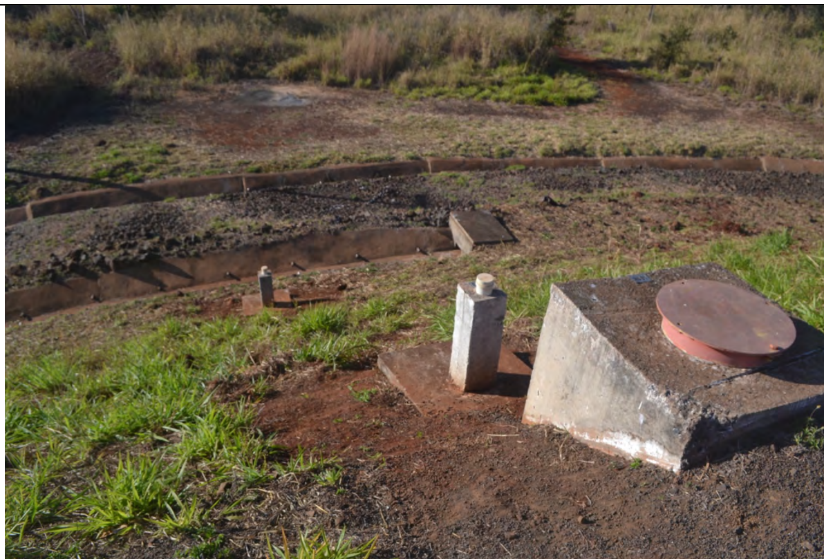
FOTO 12. MARCOS DE REFERÊNCIA E PIEZÔMETROS.
