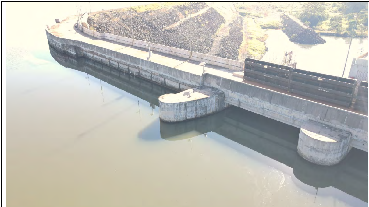
FOTO 53. VISTA DE MONTANTE DA BARRAGEM NA MARGEM ESQUERDA - SEM SINAIS DE QUALQUER COMPROMETIMENTO ESTRUTURAL.
