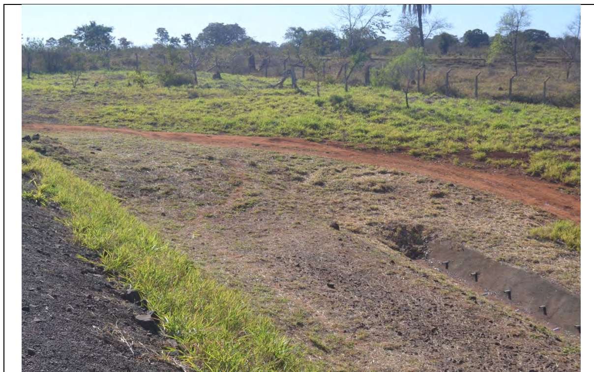
FOTO 53. INICIO DA CANALETA DE DRENAGEM, REGIÃO DA OMBREIRA AO FUNDO.
