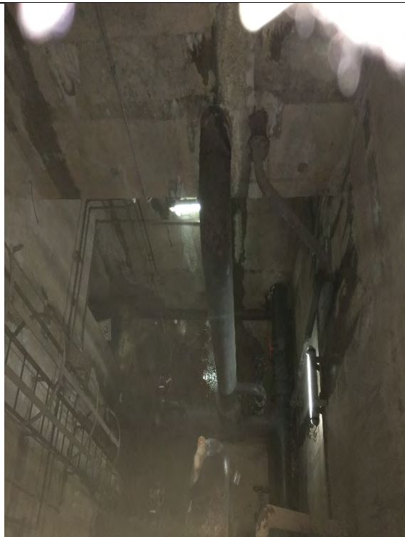
FOTO 32. POÇO DE VÁLVULAS DE DRENAGEM E ESGOTAMENTO E ACESSO A GALERIA DE DRENAGEM SUBTERRÂNEA - NÃO HOUE INSPEÇÃO NESTA REGIÃO.
