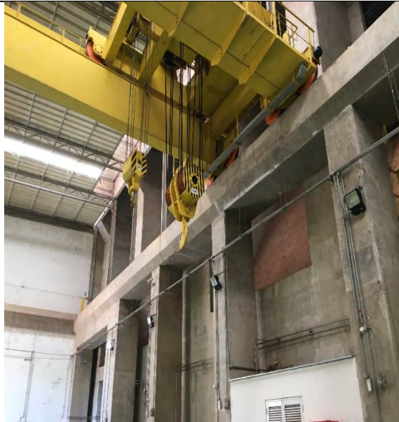
FOTO 6. PILARES E VIGAS DA PONTE ROLANTE – SEM SINAIS DE QUALQUER COMPROMETIMENTO ESTRUTURAL.
