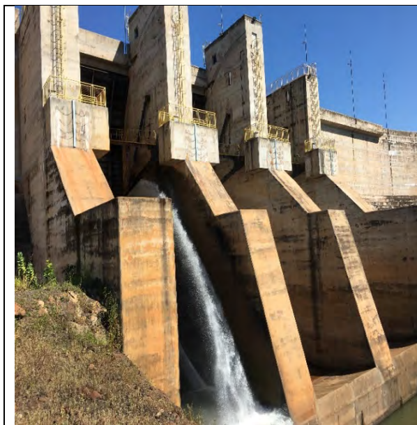
FOTO 43. VISTA DE JUSANTE DO VERTEDOURO - SEM SINAIS DE QUALQUER COMPROMETIMENTO ESTRUTURAL.
