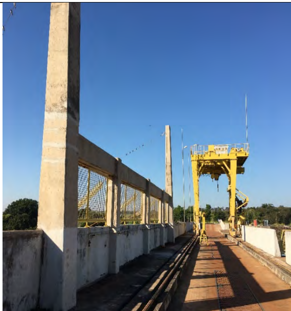
FOTO 38. CRISTA DA TOMADA D'ÁGUA E PÓRTICO DE SAÍDA DE LINHA – SEM SINAIS DE QUALQUER COMPROMETIMENTO ESTRUTURAL.
