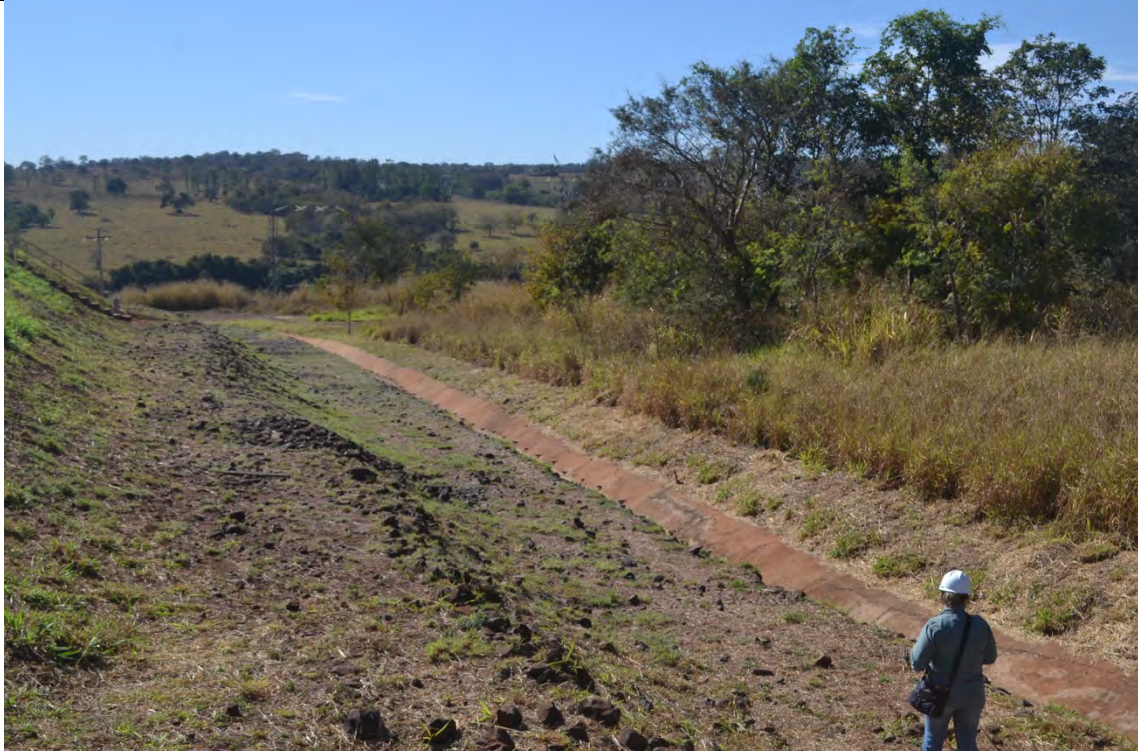
FOTO 6. CANALETA DE DRENAGEM NA FACE JUSANTE, MARGEM DIREITA.
