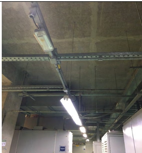
FOTO 16. LAJE DA BACIA DOS TRANSFORMADORES (TETO DA GALERIA ELÉTRICA) – SEM SINAIS DE QUALQUER COMPROMETIMENTO ESTRUTURAL.
