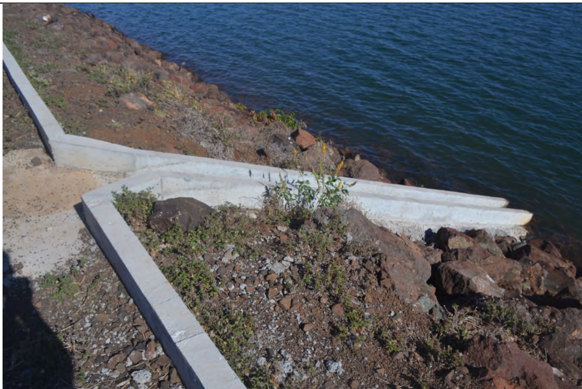
FOTO 50. DESCIDA D'ÁGUA RECÉM CONSTRUÍDA NA FACE MONTANTE.
