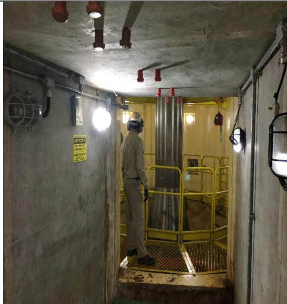
FOTO 26. GALERIA DE ACESSO AO ROTOR DO GERADOR - SEM SINAIS DE QUALQUER COMPROMETIMENTO ESTRUTURAL.
