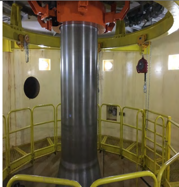
FOTO 27. PAREDES INTERNAS DO BARRIL DO GERADOR - SEM SINAIS DE QUALQUER PROBLEMA TÉRMICO OU ESTRUTURAL.
