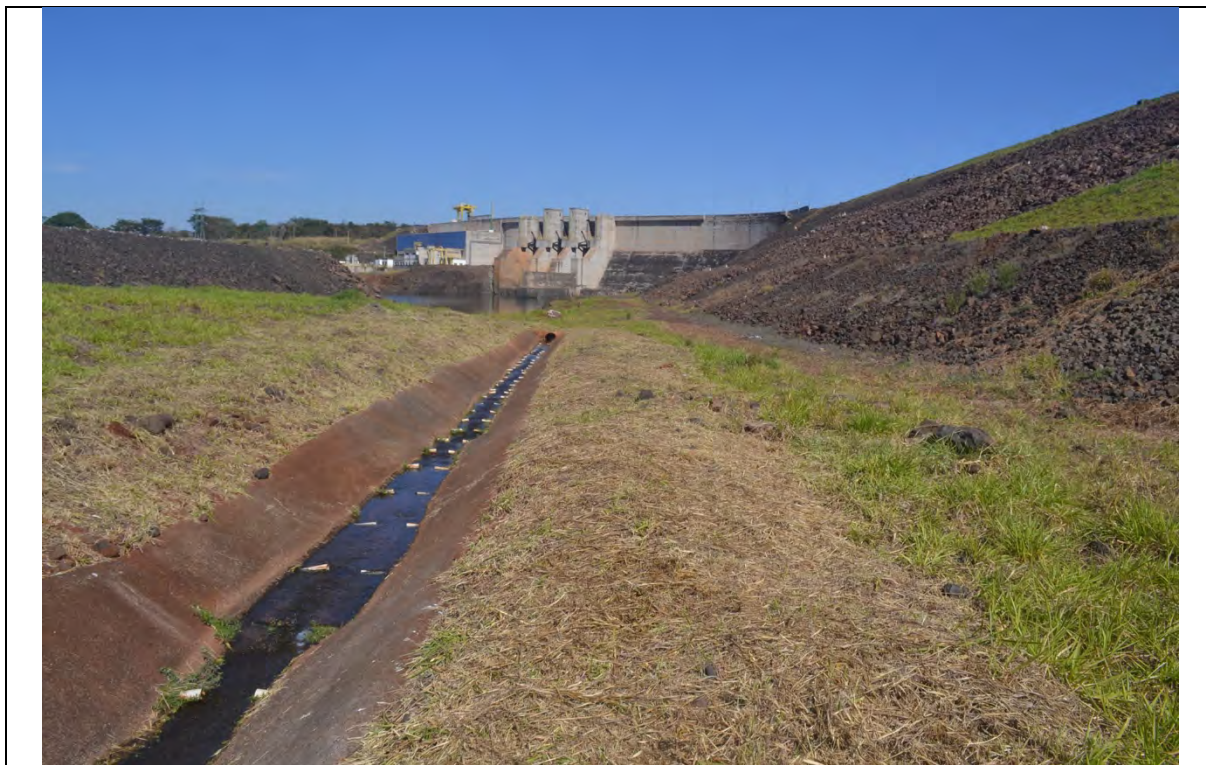
FOTO 64. CANALETA DE DRENAGEM. VISTA PARA JUSANTE.
