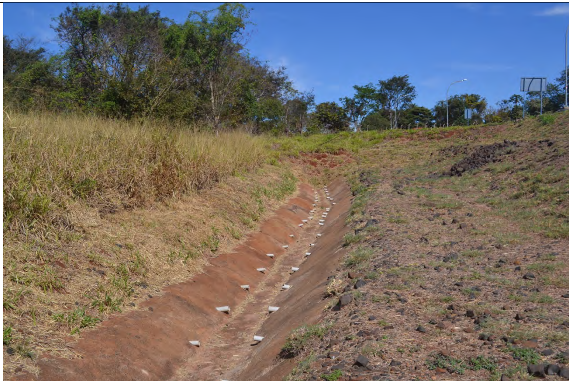
FOTO 8. INICIO DA CANALETA DE DRENAGEM NA MARGEM DIREITA, AO FUNDO A REGIÃO DA OMBREIRA MD.
