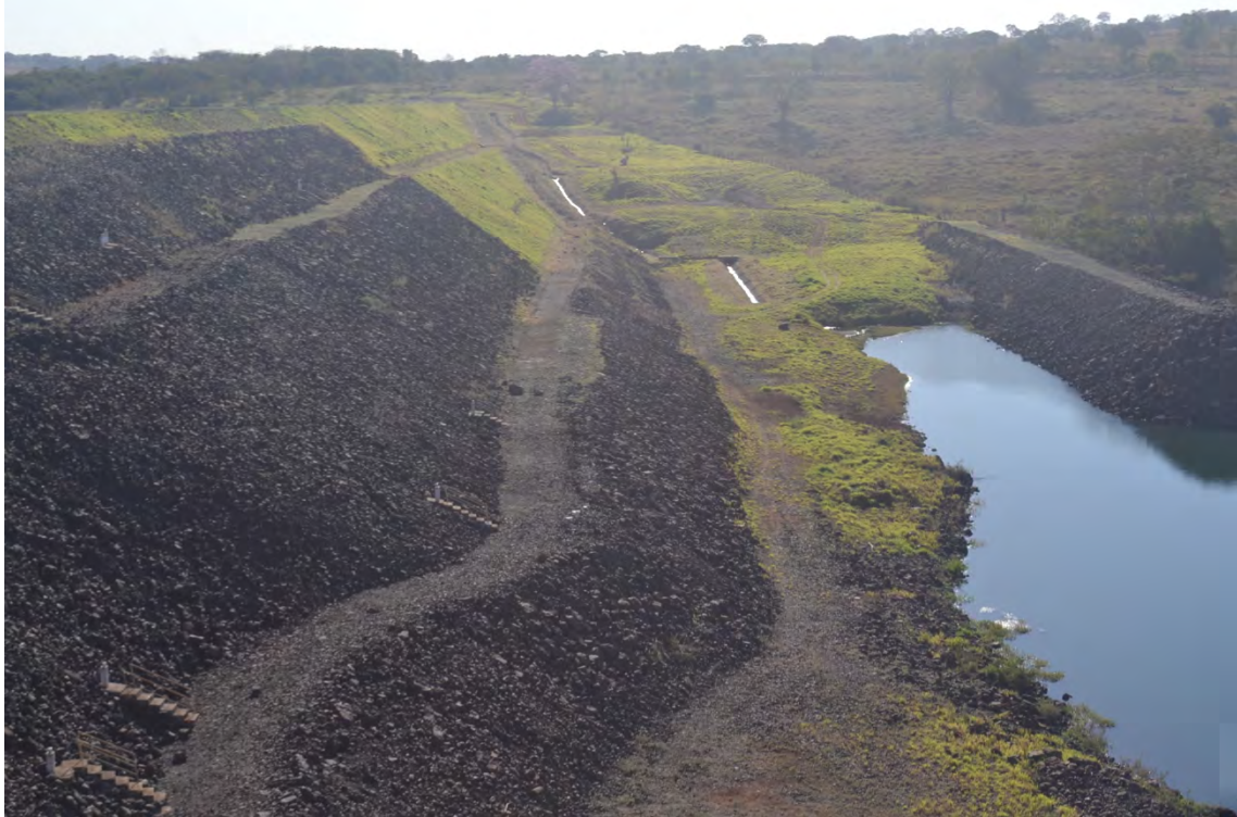
FOTO 36. BARRAGEM DA MARGEM ESQUERDA. VISTA GERAL.
