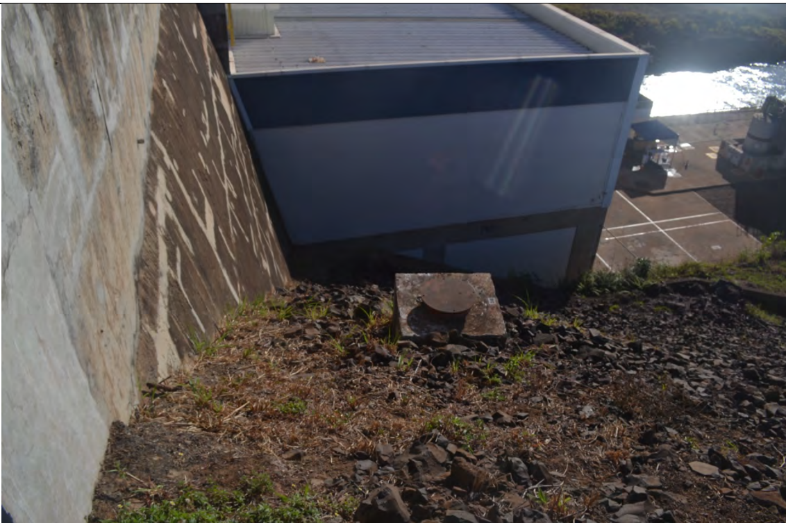
FOTO 16. DETALHE DA REGIÃO ENTRE A BARRAGEM DE TRANSIÇÃO E A BARRAGEM DE CCR.
