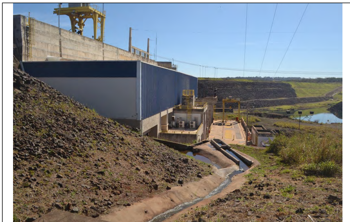
FOTO 14. PÉ DA BARRAGEM DE TRANSIÇÃO E CANALETA DE DRENAGEM. AO FUNDO A CAIXA DE COLETA DE DRENAGEM DO ENROCAMENTO DO ABRAÇO, E O MEDIDOR DE VAZÃO.
