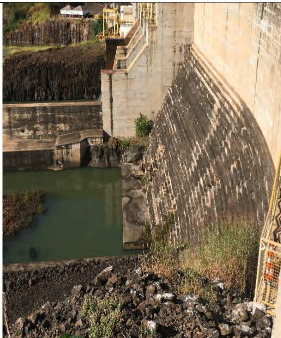
FOTO 59. VISTA DE JUSANTE DA BARRAGEM-ME – ESGOTAMENTO DA DRENAGEM DAS GALERIAS A JUSANTE - SEM SINAIS DE COMPROMETIMENTO ESTRUTURAL.
