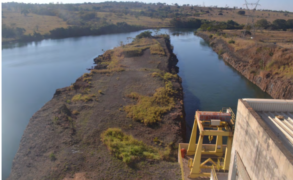
FOTO 18. CANAL DE RESTITUIÇÃO.
