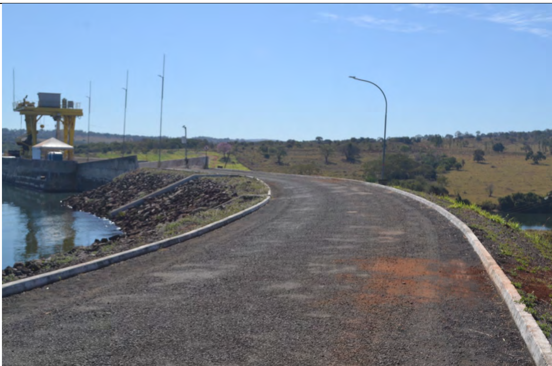
FOTO 4. CRISTA DA BARRAGEM. PAVIMENTO SEM TRINCAS.
