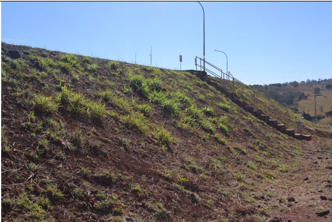
FOTO 7. FACE DO TALUDE MONTANTE PRÓXIMO A OMBREIRA.
