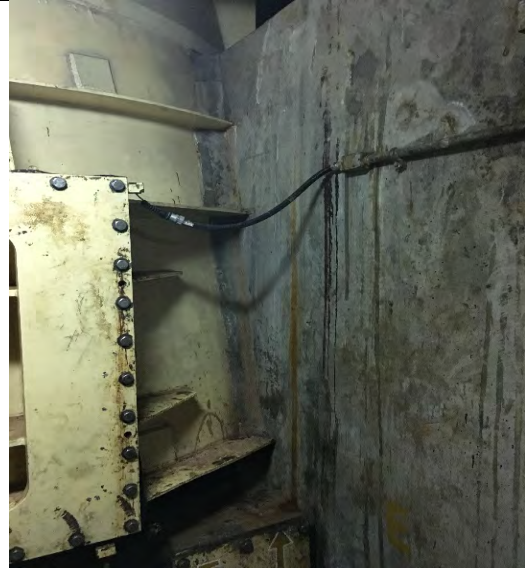
FOTO 31. CONCRETO DE 2º ESTÁGIO DA CAIXA ESPIRAL - SEM SINAIS DE QUALQUER COMPROMETIMENTO ESTRUTURAL.
