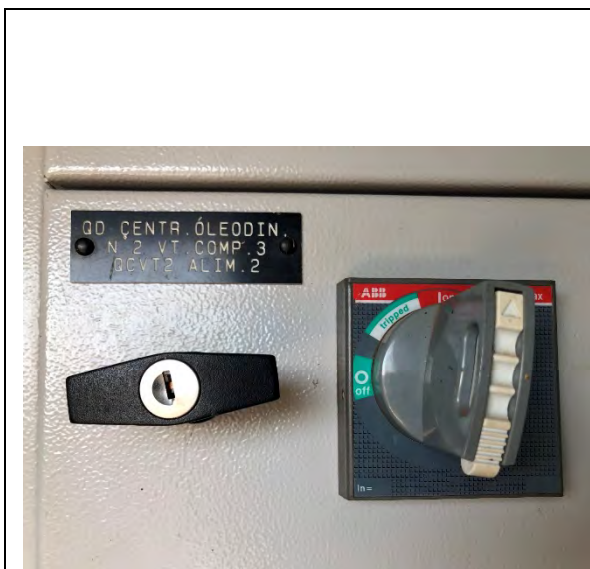
QDVT – Gaveta para alimentação AC 2 da central hidráulica 1 – Tag aparentemente errado
