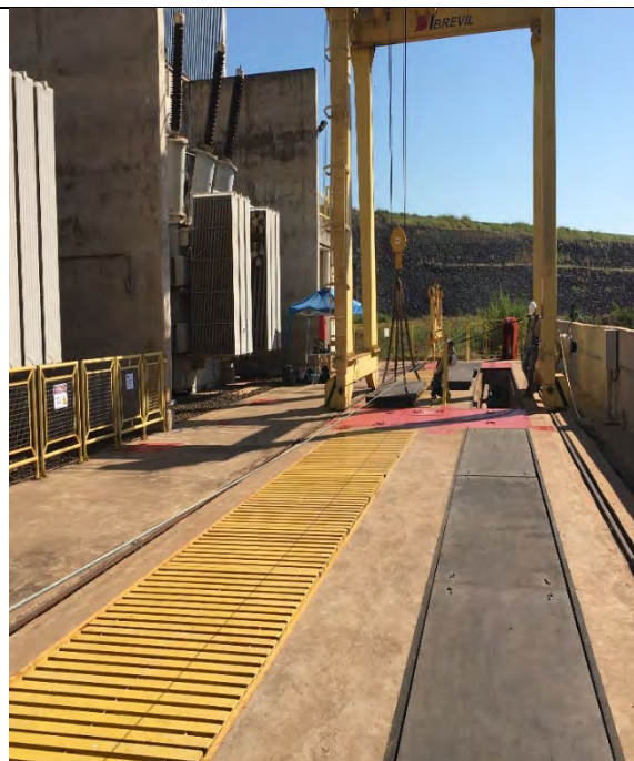
FOTO 3. LAJE DO PÓRTICO DA SUCÇÃO – SEM SINAIS DE QUALQUER COMPROMETIMENTO ESTRUTURAL.
