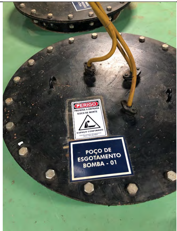
Tampa do poço de esgotamento – passagem do cabeamento da motobomba 1
