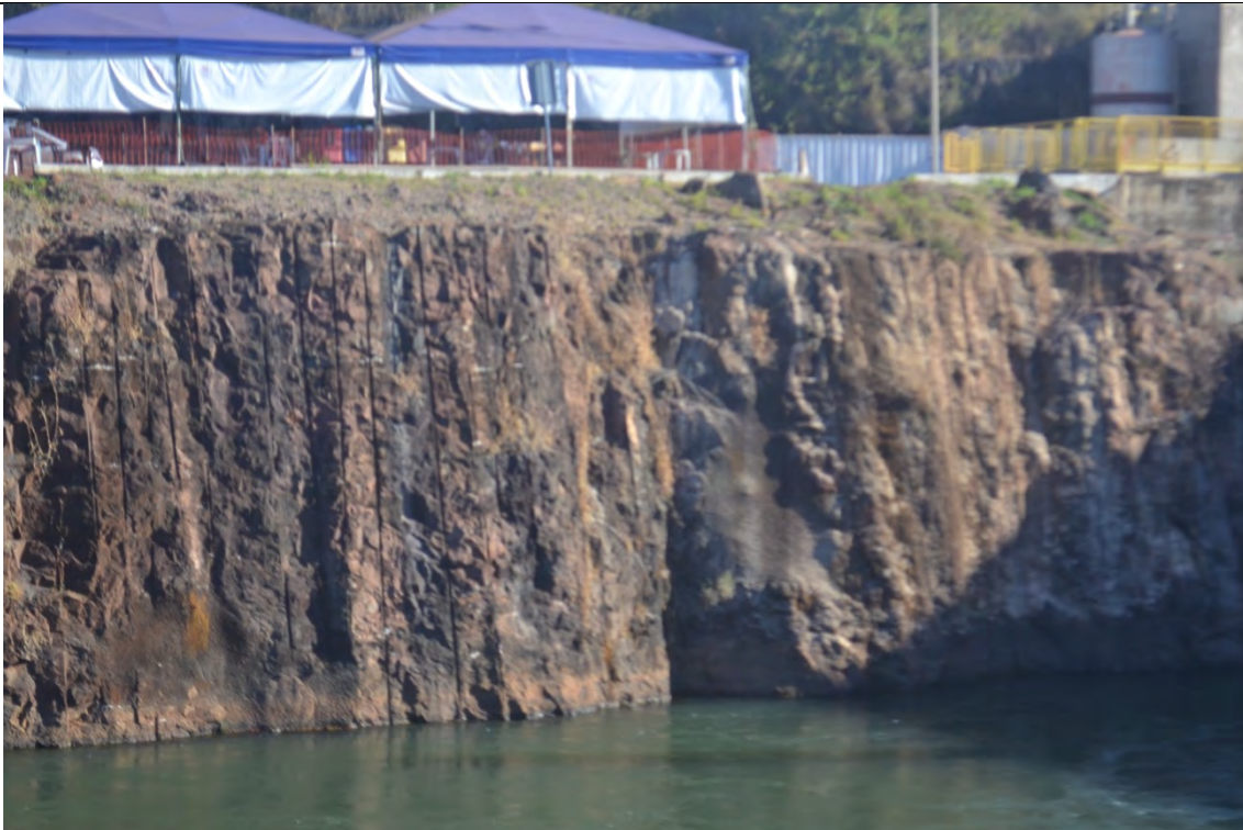
FOTO 23. DETALHE DO TALUDE EM ROCHA NA MARGEM DIREITA.
