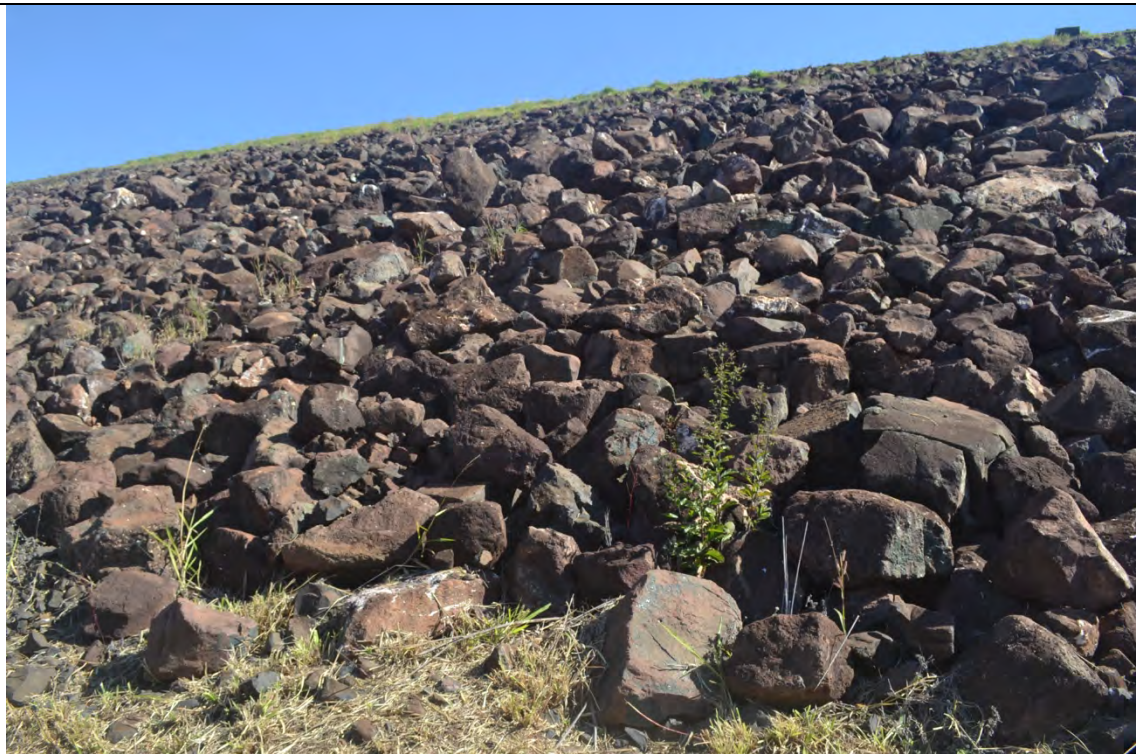
FOTO 45. DETALHE DO ENROCAMENTO, COM VEGETAÇÃO ARBUSTIVA.
