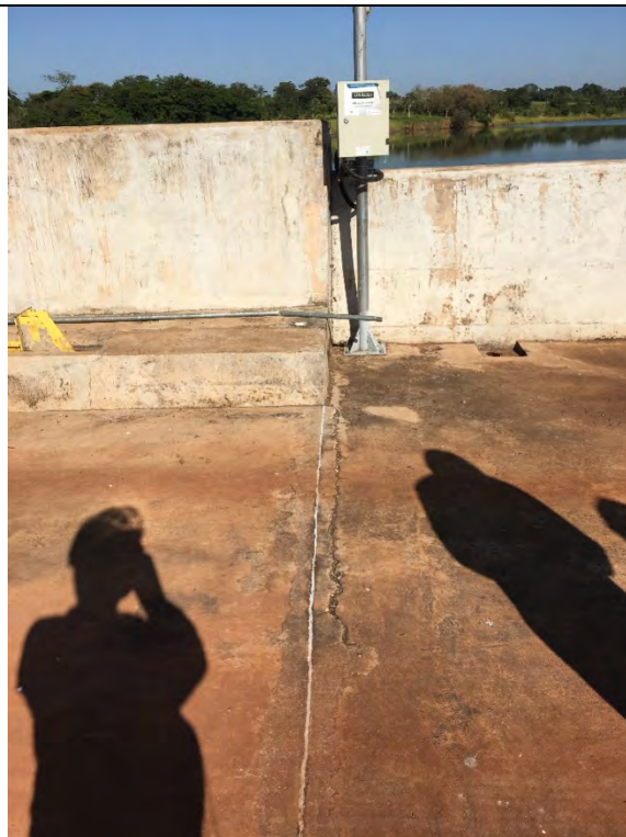
FOTO 56. JUNTA DE CONTRAÇÃO ENTRE O VERTEDOIRO E A BARRAGEM-ME – SEM SINAIS MOVIMENTAÇÕES ANORMAIS – TRINCA NA ARGAMASSA DE ACABAMENTO – NÃO É NECESSÁRIO REPARO ALGUM, POIS NÃO É ESTRUTURAL.
