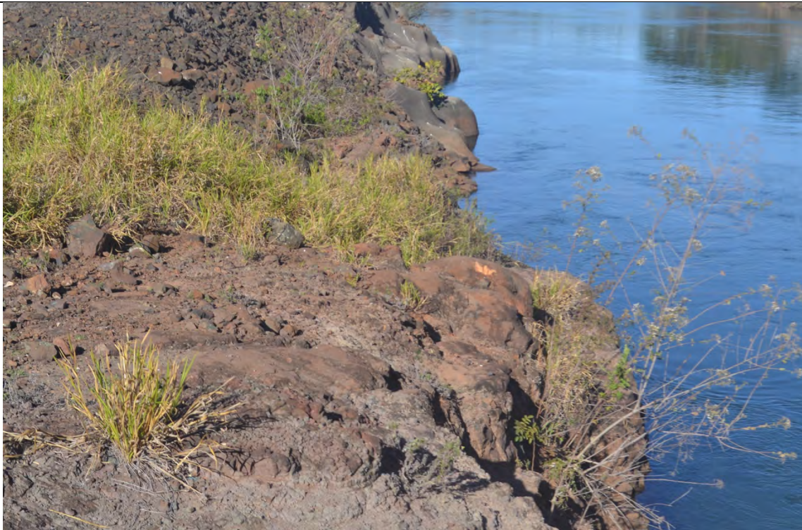
FOTO 21. DETALHE DOS RAVINAMENTOS NA MARGEM ESQUERDA.
