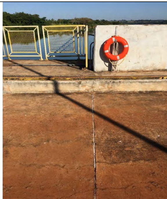
FOTO 40. JUNTA DE CONTRAÇÃO ENTRE A TOMADA D'ÁGUA E A BARRAGEM DE LIGAÇÃO – SEM SINAIS MOVIMENTAÇÕES ANORMAIS.
