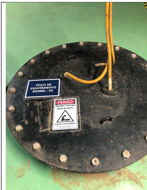
Tampa do poço de esgotamento – passagem do cabeamento da motobomba 2
