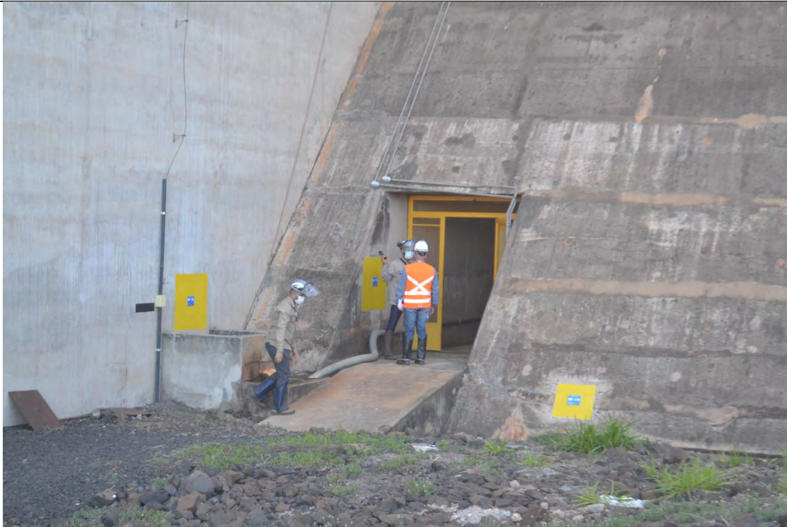
FOTO 31. ENTRADA PARA GALERIA DE DRENAGEM.
