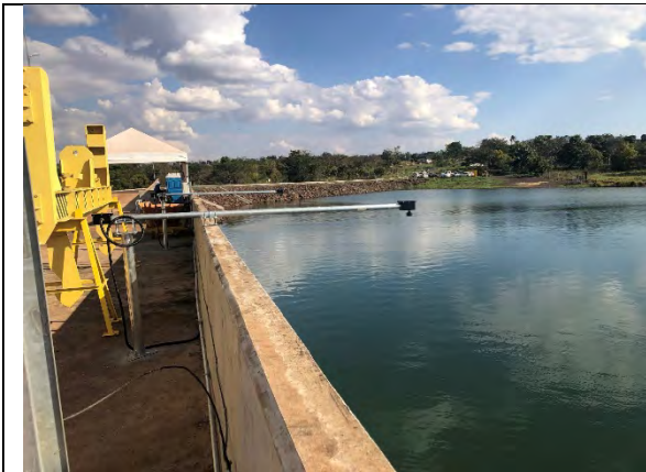
Sistemas de Medições Hidráulicas – Sondas ultrassônicas para medição do nível de montante
