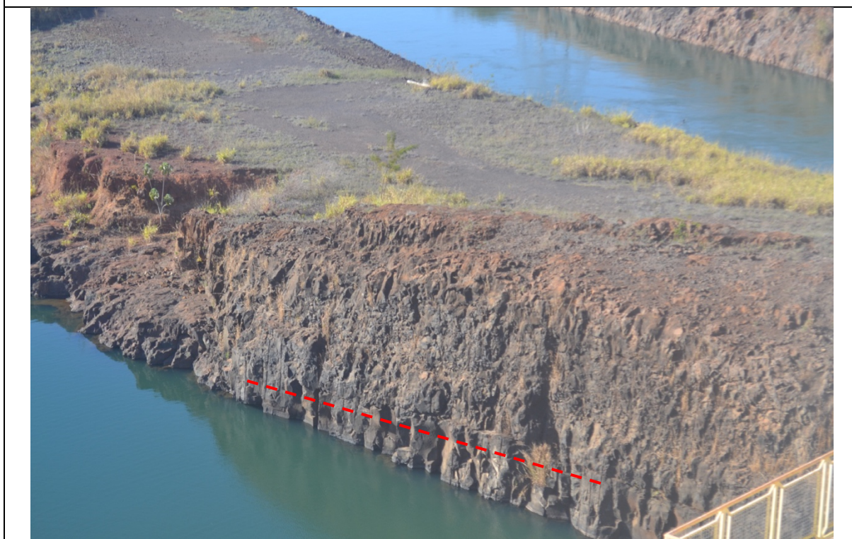
FOTO 26. DETALHE DA FOTO ANTERIOR, COM O TRAÇADO APROXIMADO DA JUNTA-FALHA. NÃO SE OBSERVAM NO TALUDE SINAIS DE INSTABILIDADE OU SURGÊNCIAS DE ÁGUA.
