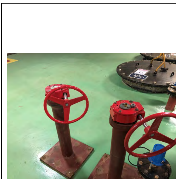
Tampa do poço de esgotamento – passagem do cabeamento da motobomba 2
