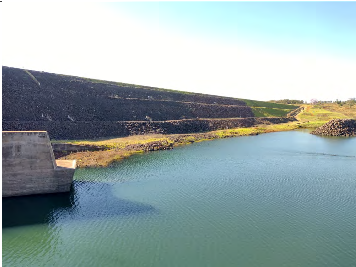
FOTO 37. VISÃO PANORÂMICA DA BARRAGEM NA MARGEM ESQUERDA.
