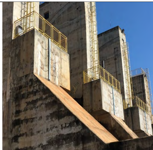
FOTO 46. VIGAS MUNHÃO – SEM SINAIS VISUAIS DE DESCOMPRESSÃO DA JUNTA PROTENDIDA DA VIGA COM O PILAR DO VT.
