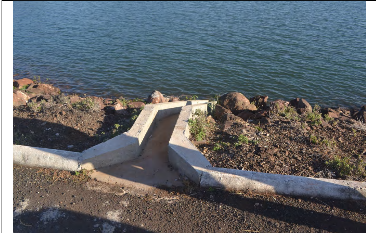
FOTO 5. DETALHE DA DESCIDA D'ÁGUA EM CONCRETO.
