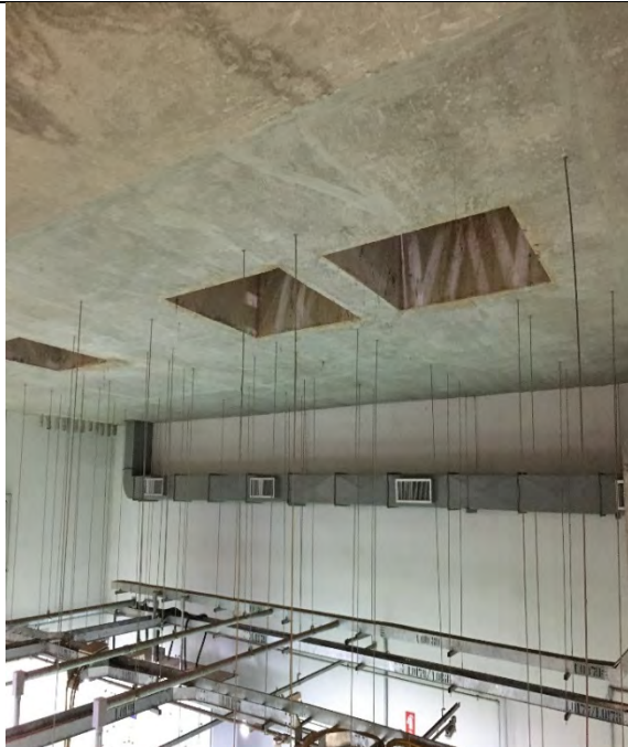
FOTO 22. ABERTURA NA LAJE PARA DESCIDA DAS BOMBAS NOS POÇOS DE DRENAGEM E ESGOTAMENTO – SEM SINAIS DE QUALQUER COMPROMETIMENTO ESTRUTURAL.
