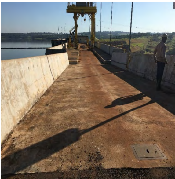
FOTO 36. CRISTA DA BARRAGEM DE TRANSIÇÃO NA MD - SEM SINAIS DE QUALQUER COMPROMETIMENTO ESTRUTURAL.
