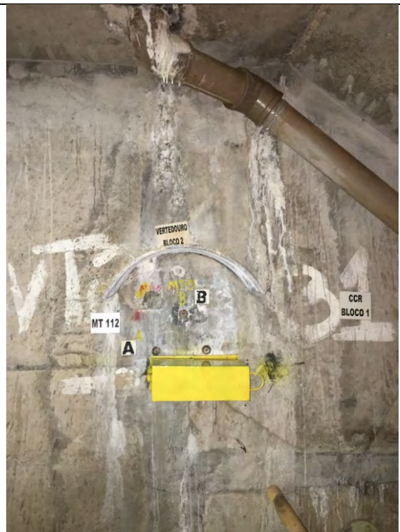
FOTO 52. JUNTA DE CONTRAÇÃO ENTRE O VERTEDOIRO E A BARRAGEM - SEM SINAIS MOVIMENTAÇÕES ANORMAIS .
