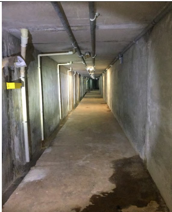
FOTO 60. GALERIA DE DRENAGEM DA BARRAGEM-ME – NO GERAL SEM SINAIS DE COMPROMETIMENTO ESTRUTURAL.
