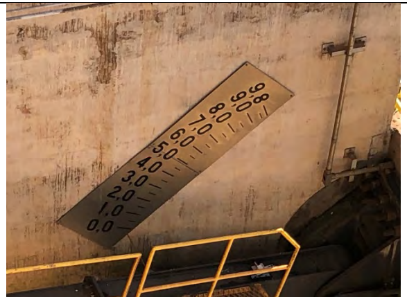
Régua de medição da posição da comporta
