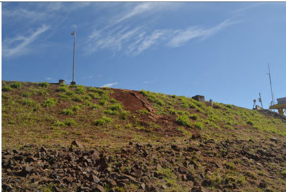
FOTO 10. LOCAL ONDE FOI INSTALADA A BIOMANTA.
