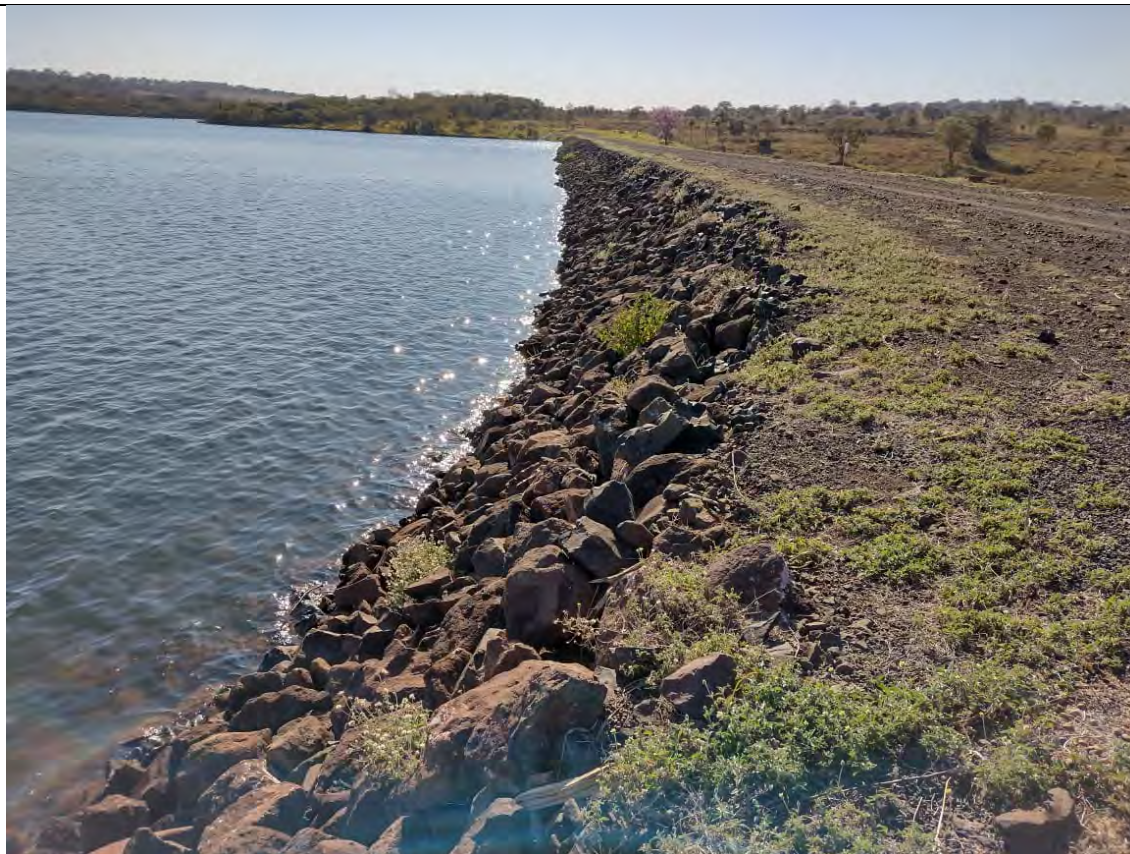
FOTO 51. CRISTA E ENROCAMENTO NA FACE MONTANTE.
