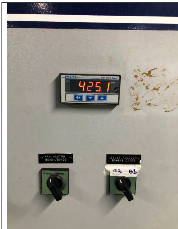
Início dos testes de operação manual da motobomba
