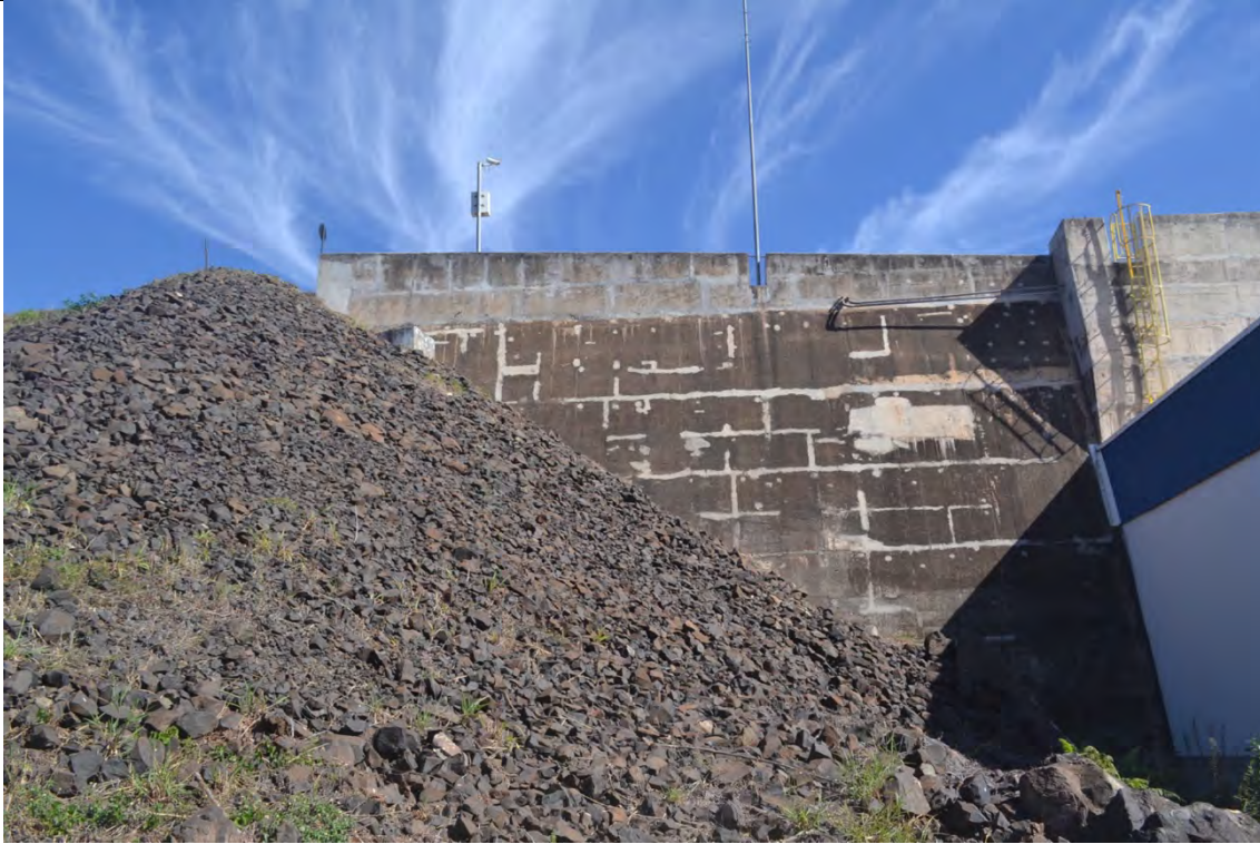
FOTO 15. DETALHE DO ENROCAMENTO NO ENCONTRO COM A BARRAGEM DE CCR.
