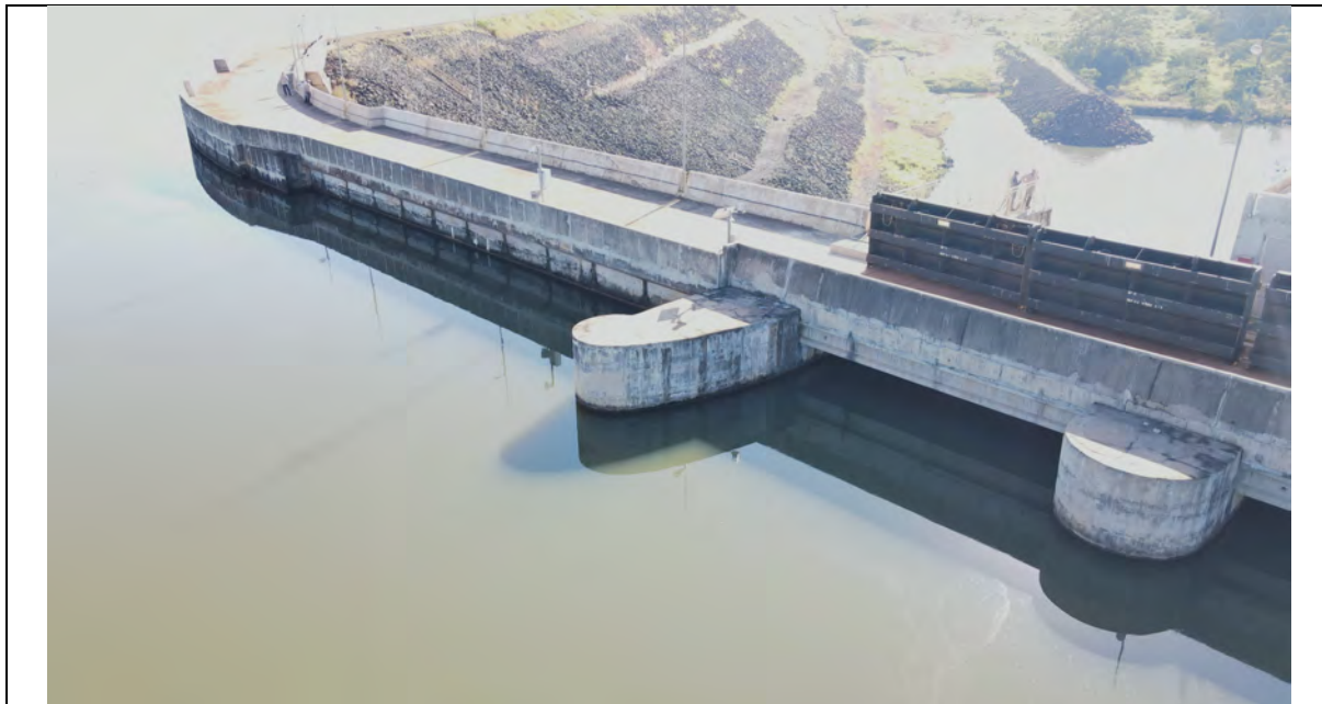
FOTO 42. VISTA DE MONTANTE DO VERTEDOURO- SEM SINAIS DE QUALQUER COMPROMETIMENTO ESTRUTURAL.
