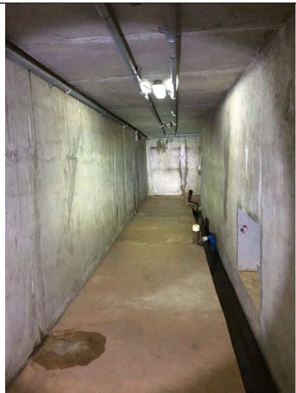
FOTO 51. GALERIA DE DRENAGEM DO VERTEDOIRO – DRENAGEM OPERANTE - SEM SINAIS DE QUALQUER COMPROMETIMENTO ESTRUTURAL.
