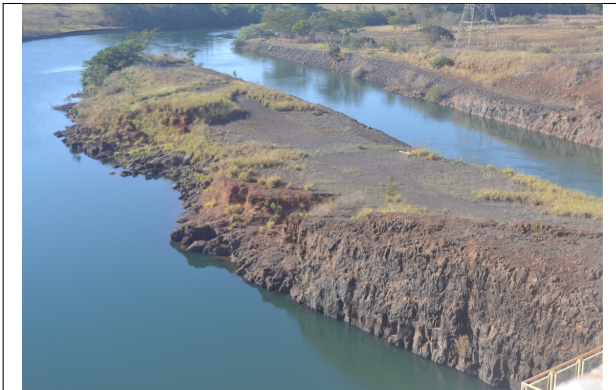
FOTO 25. MARGEM DIREITA. AO FUNDO O CANAL DE RESTITUIÇÃO.
