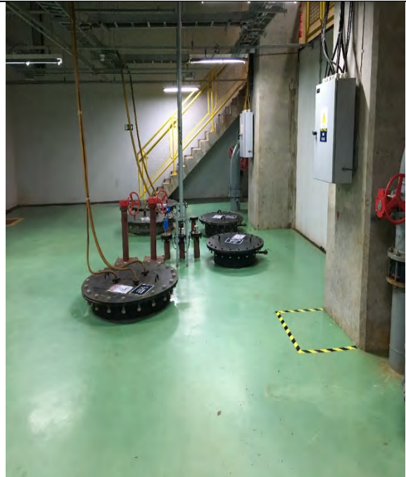
FOTO 23. LAJE ESTANQUE DOS POÇOS DE DRENAGEM E ESGOTAMENTO – SEM SINAIS DE QUALQUER COMPROMETIMENTO ESTRUTURAL.
