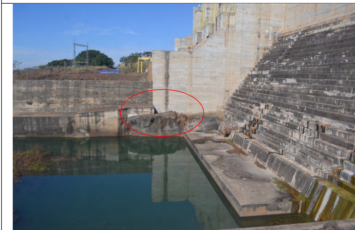
FOTO 29. DETALHE DO PEQUENO REMANESCENTE ROCHOSO JUNTO À ESTRUTURA, SEM ANOMALIAS.
