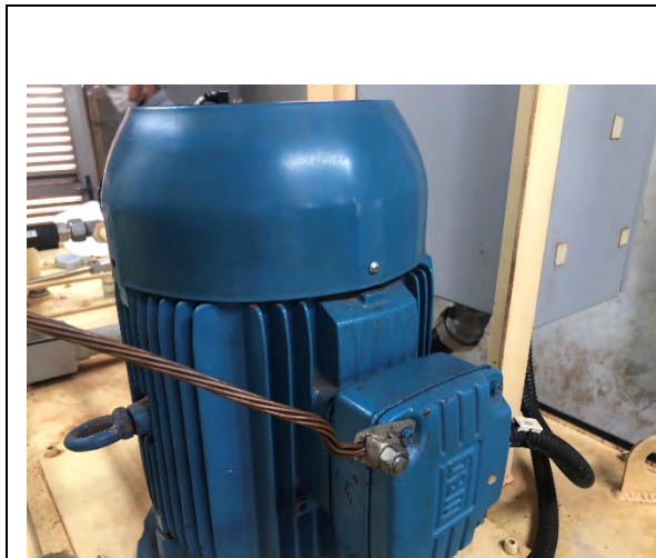
QSVT – Cabos sem anilhas com etiquetas temporárias – Aparentemente da época da construção
