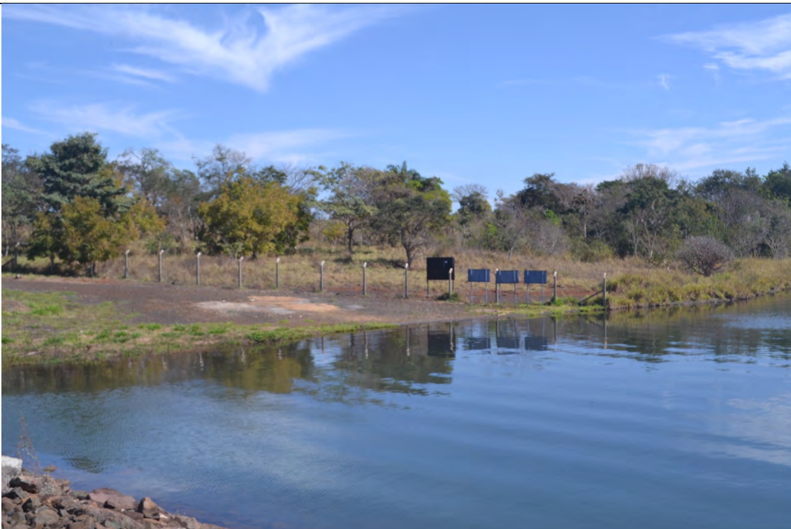
FOTO 2. REGIÃO DA OMBREIRA NA MARGEM DIREITA VISTA MONTANTE.
