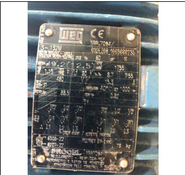
Placa do Motor de uma das bombas da unidade hidráulica – tensão 480 V
