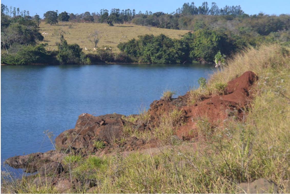
FOTO 22. VISTA PARA JUSANTE, EM DIREÇÃO À MARGEM ESQUERDA.
