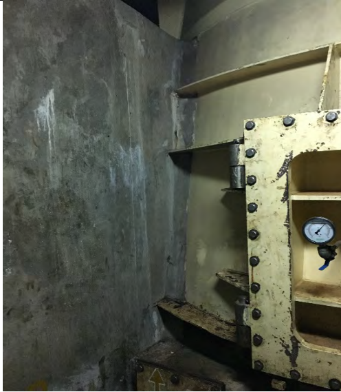
FOTO 30. CONCRETO DE 2º ESTÁGIO DA CAIXA ESPIRAL - SEM SINAIS DE QUALQUER COMPROMETIMENTO ESTRUTURAL.
