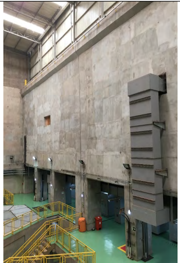
FOTO 9. PAREDES E PILARES DE JUSANTE DA CASA DE FORÇA (UG1 E UG2) – SEM COMPROMETIMENTO ESTRUTURAL VISÍVEL.
