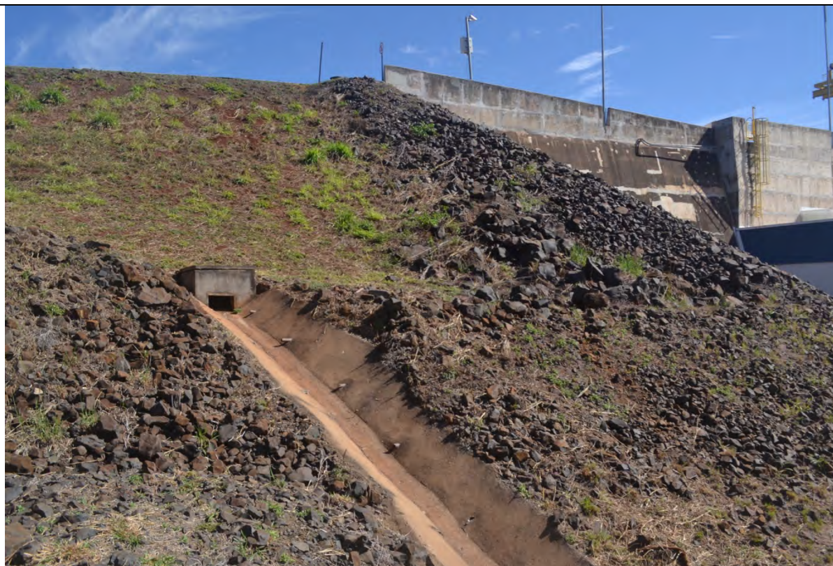
FOTO 13. REGIÃO DE TRANSIÇÃO ENTRE BARRAGEM DE TERRA E O ENROCAMENTO.
