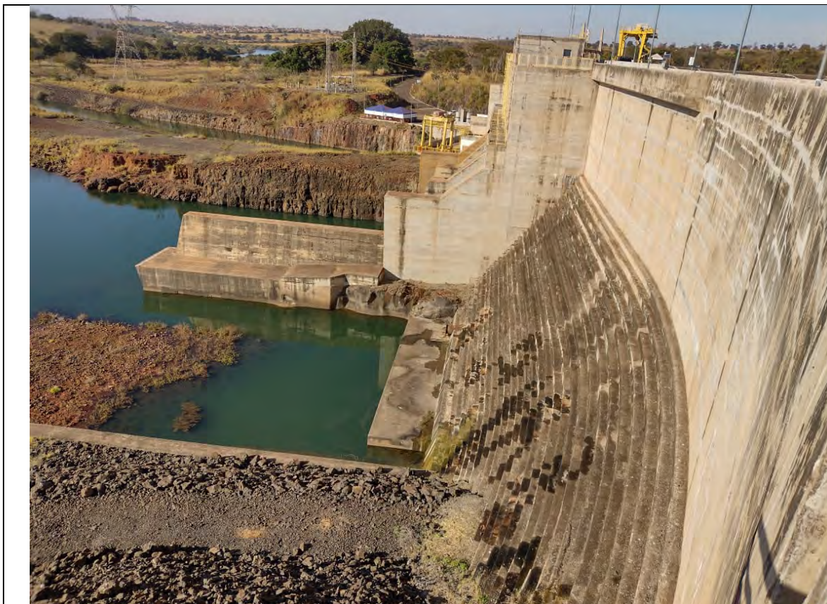
FOTO 28. REGIÃO JUSANTE DA BARRAGEM DE CCR.
