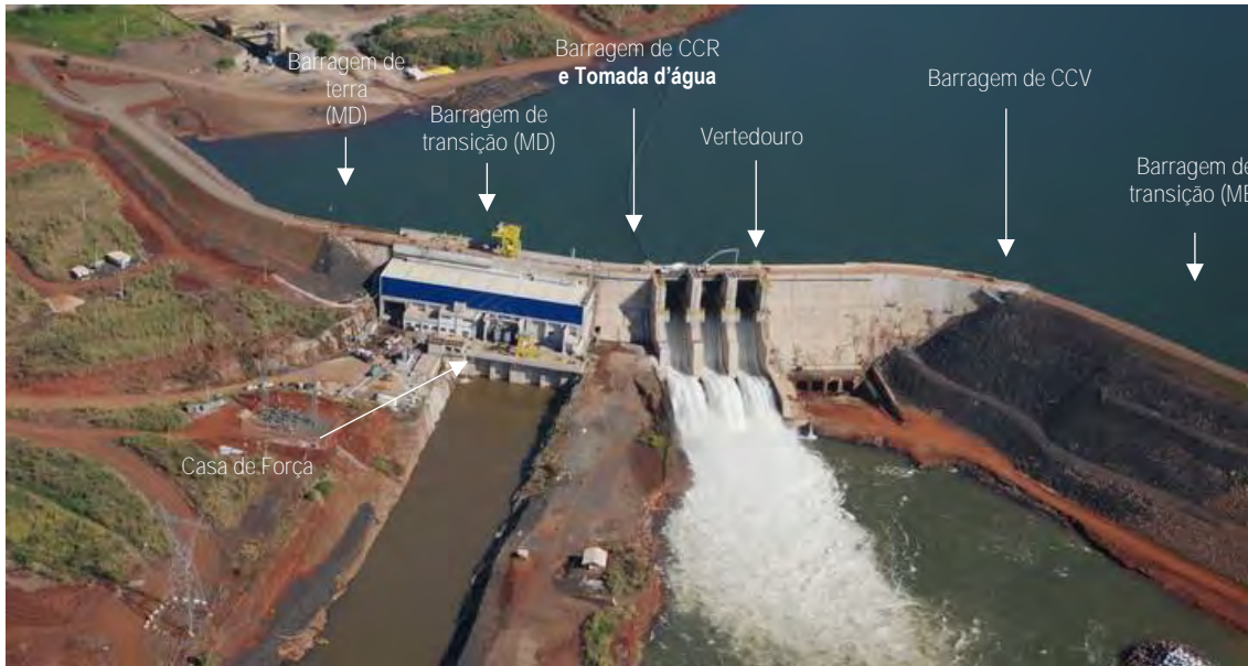
Figura 6. Vista geral do empreendimento. Fonte: Kinross.
