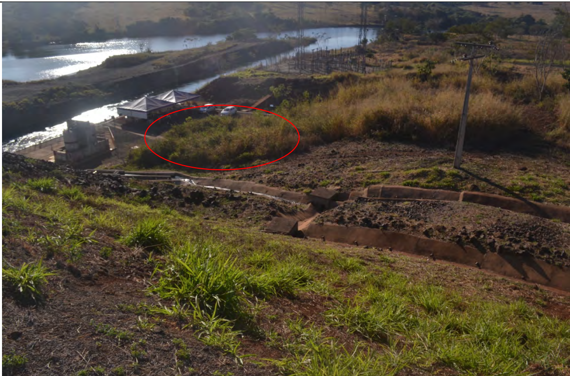
FOTO 70. VISTA DAS CANALETAS E DA ÁREA ÚMIDA.
