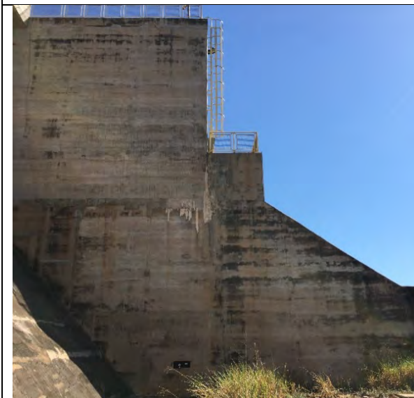
FOTO 47. PILAR LATERAL DO VERTEDOIRO - SEM SINAIS DE QUALQUER COMPROMETIMENTO ESTRUTURAL.
