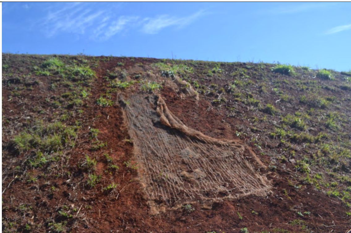
FOTO 9. TRATAMENTO E RECUPERAÇÃO DA FACE DO TALUDE COM BIOMANTA.
