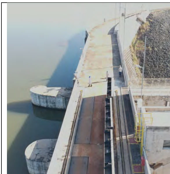
FOTO 54. CRISTA DA BARRAGEM EM CCR E DO MURO DE TRANSIÇÃO-ME COM A BARRAGEM DE TERRA – SEM SINAIS DE COMPROMETIMENTO ESTRUTURAL.
