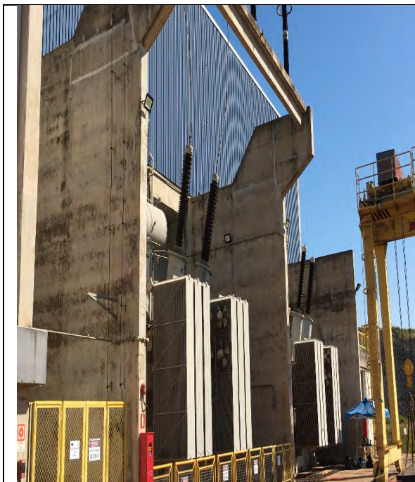
FOTO 2. PAREDES CORTA FOGO E ESTRUTURA DE SAÍDA DE LINHA – SEM SINAIS DE QUALQUER COMPROMETIMENTO ESTRUTURAL.
