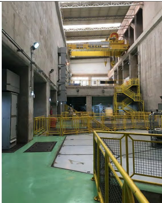
FOTO 14. LAJE DO PISO DO GERADOR – SEM SINAIS DE QUALQUER COMPROMETIMENTO ESTRUTURAL.
