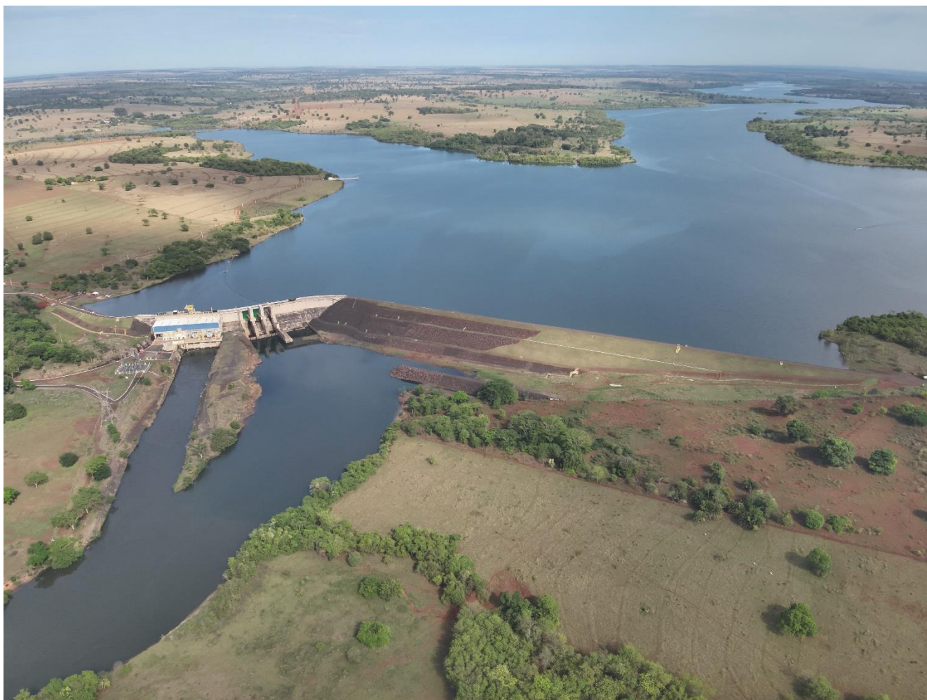
Foto Drone 01 - Vista geral Usina Hidrelétrica Caçu, novembro 2024.
