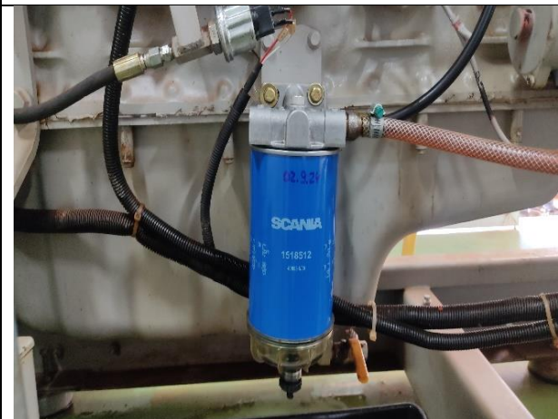
Figura 09- Substituição do Filtro de Separador de Água/Óleo .
