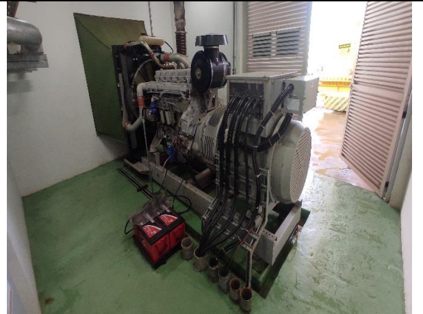
Figura 14- Limpeza de toda Área do Gerador Diesel de Emergência.
