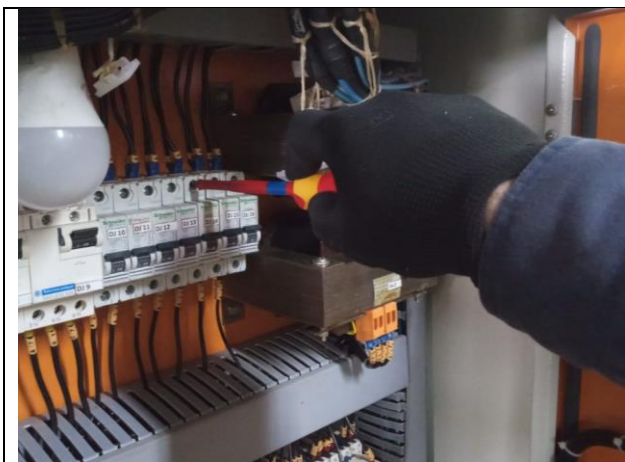
Inspeção e limpeza geral nos quadros de comando
