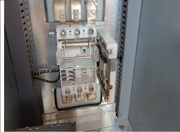
Figura 24 – Inspeção interna de acoplamento do disjuntor
