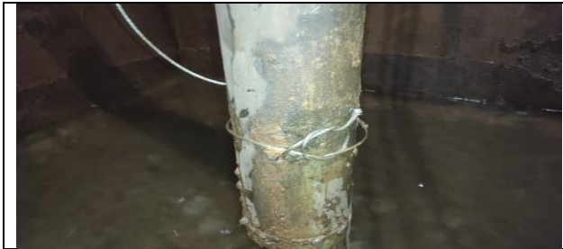
Figura 49: Inspeção realizada no poço, verificando estado de conservação de modo geral.
