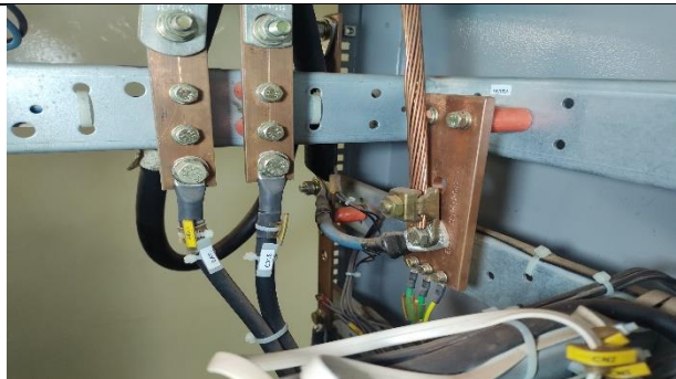
Figura 03: Realização de inspeção geral no painel.
