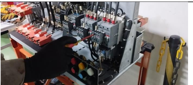
Figura 10: Realizado reaperto das conexões das gavetas.
