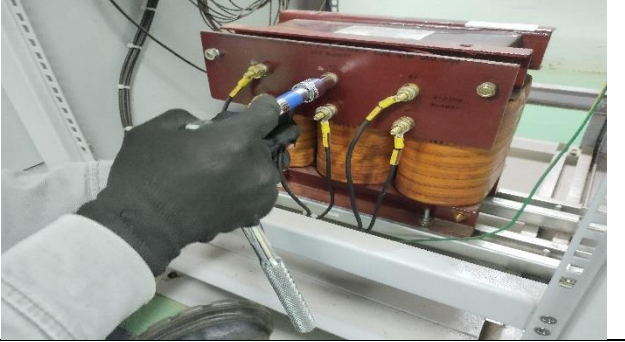
Figura 12: Realizado torque ideal de 15Nm nas conexões do Retificador 48Vcc.
