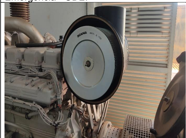
Figura 03 - Substituição do Filtro de Ar.
