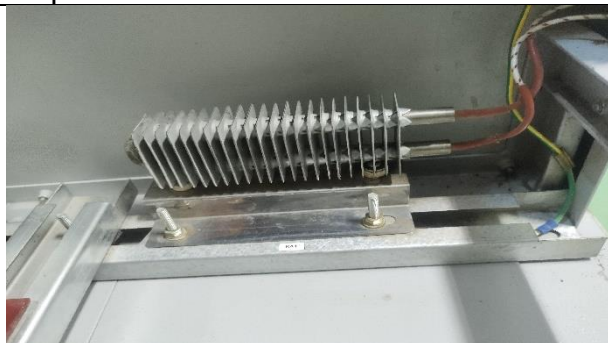
Figura 28: Realizada verificação na resistência presente no painel.
