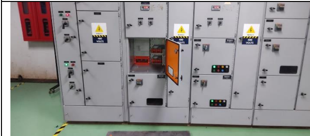
Figura 03: Realizado bloqueio das gavetas das bombas.
