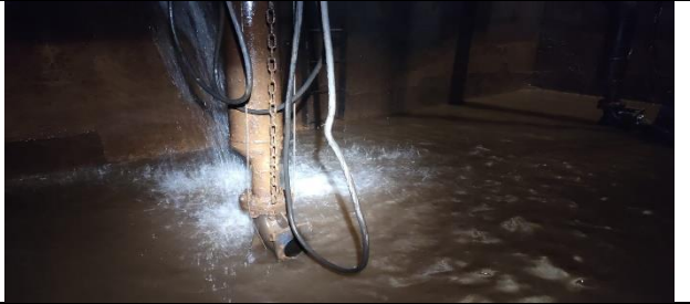
Figura 52: Inspeção realizada no poço, verificando estado de conservação de modo geral.
