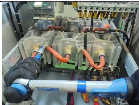
Figura 13: Realização de torqueamento dos pontos de conexão.
