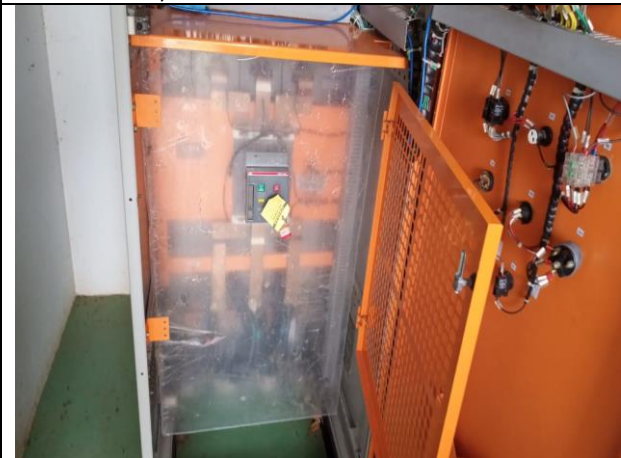
Figura 19 - Melhoria Instalação do acrílico
