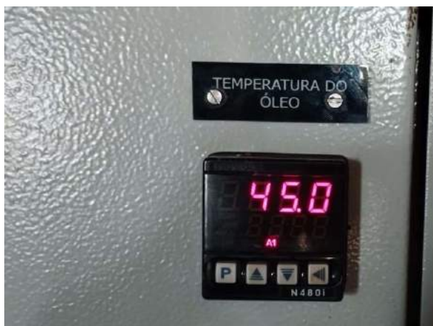
Figura 32 – Normalizado medição de temperatura da central UHVT-01-02
