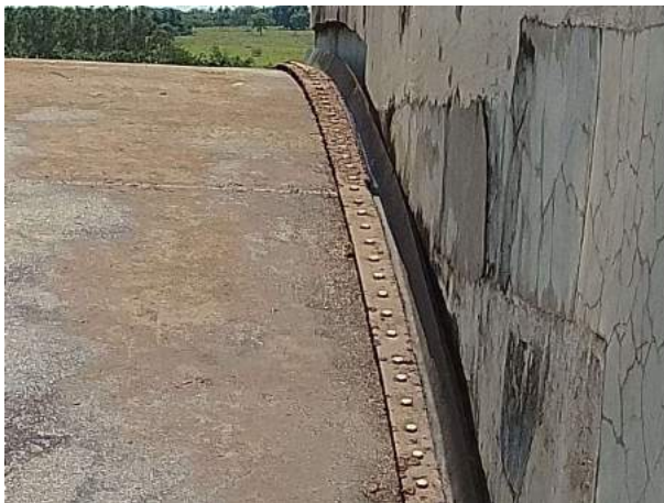
Figura 67 – Manobra de acionamento completa da comporta 02
