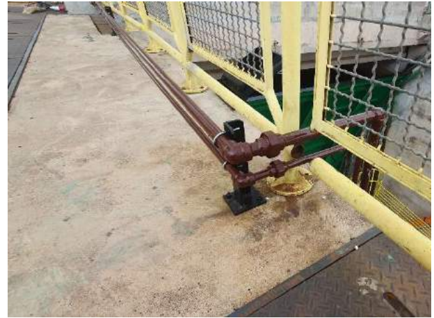
Figura 37 – Inspeção nas tubulações e conexões do VT - 1
