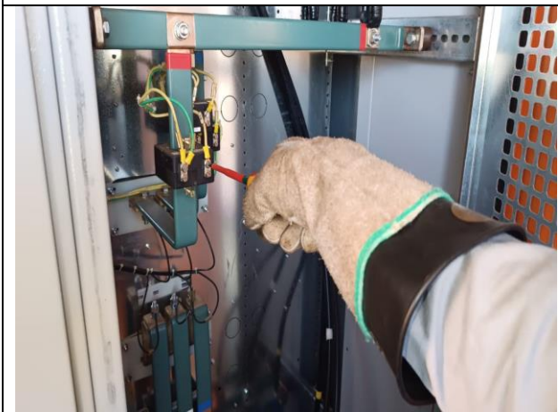
Figura 15 – Inspeção nos TC's e conferencia de reaperto
