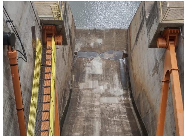
Inspeção visual braços da comporta
