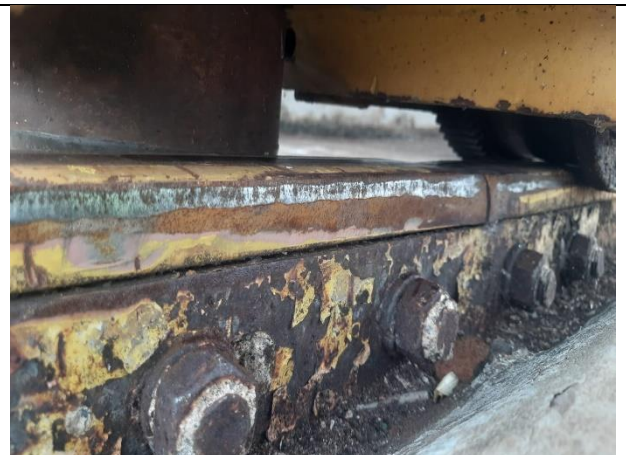
Figura 06 – Desgastes no trilho, onde ocorre o travamento do Pórtico
