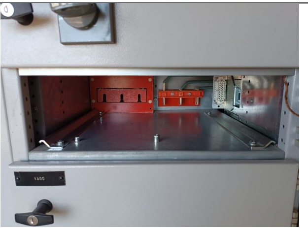
Figura 06 – Limpeza nicho das gavetas
