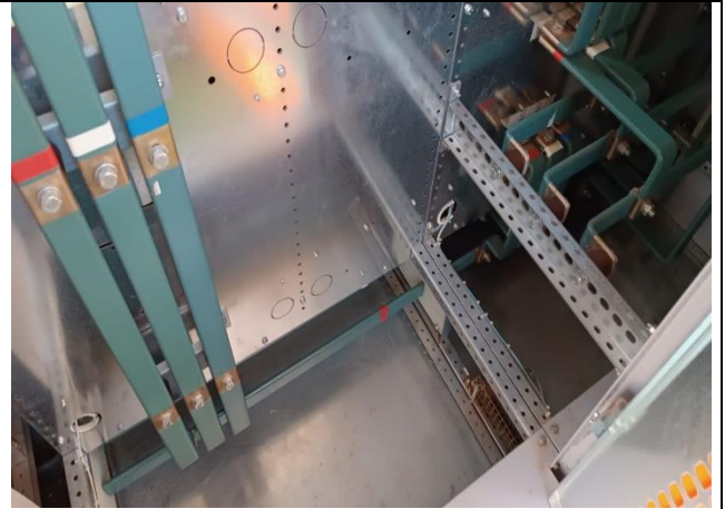
Figura 20 – Inspeção dos barramentos e limpeza interna
