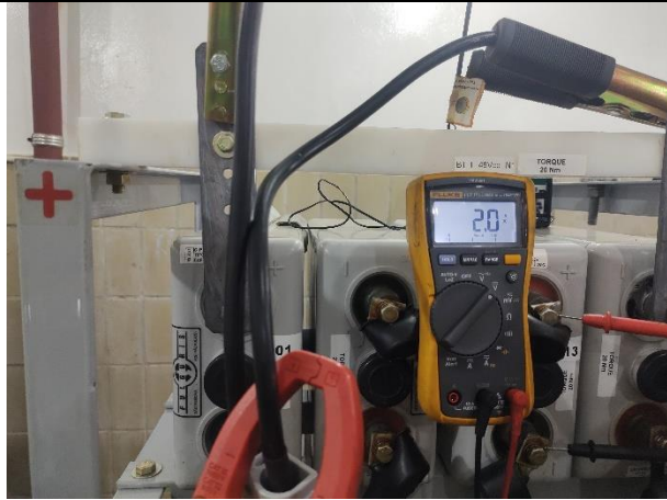
Figura 31 – Medição de tensão VPE do ciclo 6hs.
