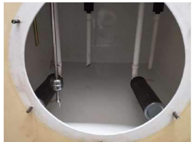
Figura 10 – Limpeza da central UHVT-01-02 e inspeção no interior do tanque
