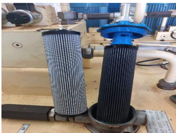
Figura 13 – Substituição dos filtros de retorno UHVT-01-02
