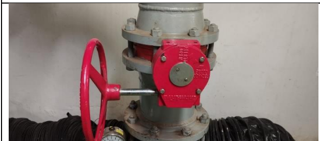
Figura 63: Verificação de funcionamento das válvulas da tubulação do poço de drenagem.
