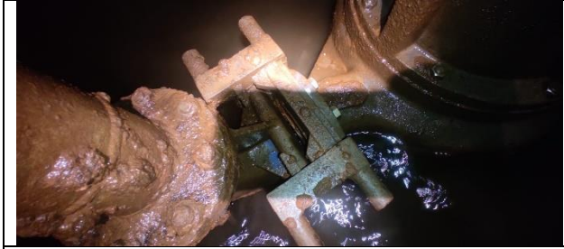
Figura 45: Inspeção realizada no poço, verificando estado de conservação das bombas no geral.
