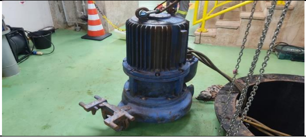
Figura 56: Bombas retiradas do poço.
