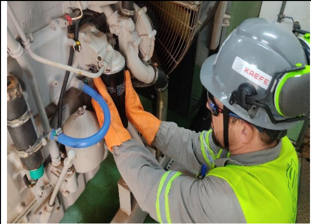
Figura 08- Filtro Novo Instalado.
