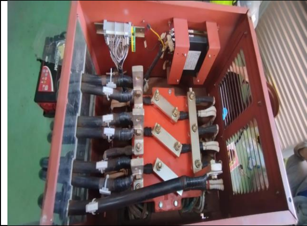
Figura 17 - Reaperto das conexões.
