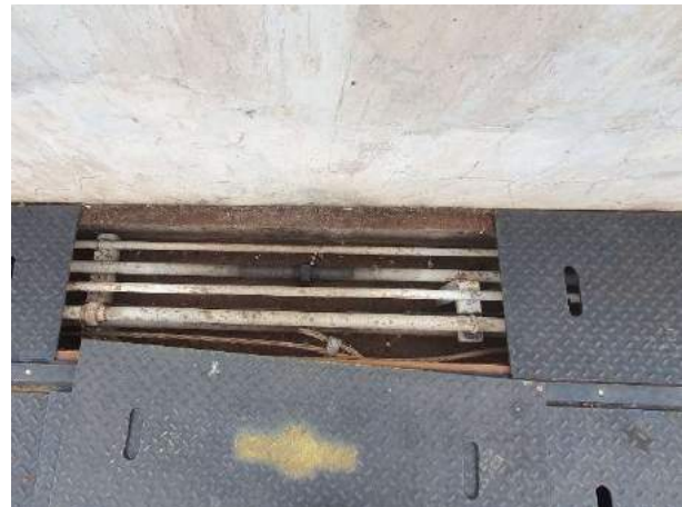
Figura 71 – Inspeção nas tubulações e conexões do VT - 2
