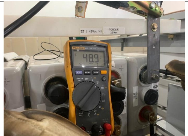
Figura 16 – Medições de tensão do ciclo 1hs.
