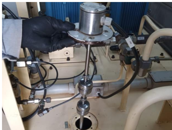
Testes na chave de nível UHVT-03
