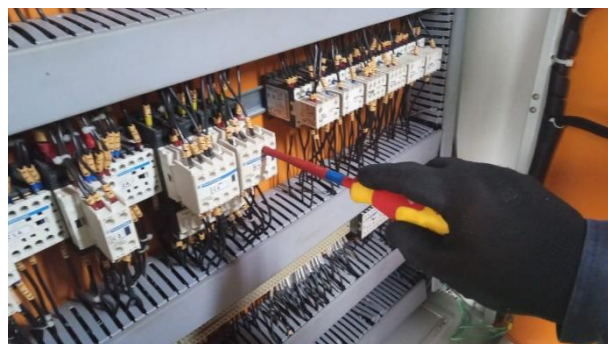
Reaperto nas conexões e bornes dos quadros VT - 3
