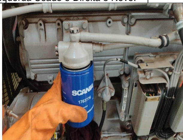
Figura 06 - Filtro Novo de Combustível.
