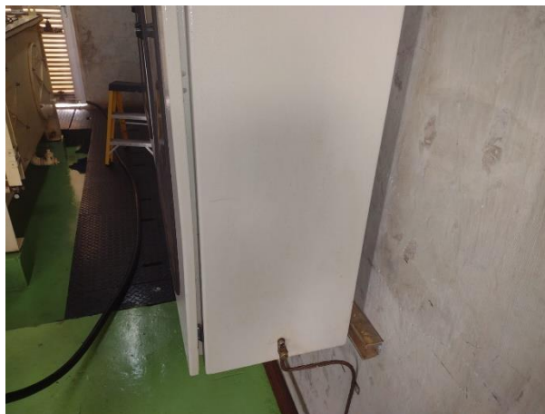
Inspeção no estado dos aterramentos dos quadros
