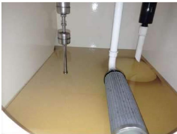
Figura 09 – Drenagem do óleo da central UHVT-01-02 e inspeção interna
