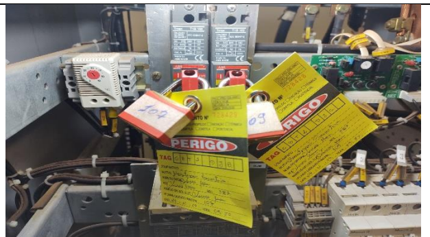
Figura 04: Realização de bloquei CBT1 48Vcc.
