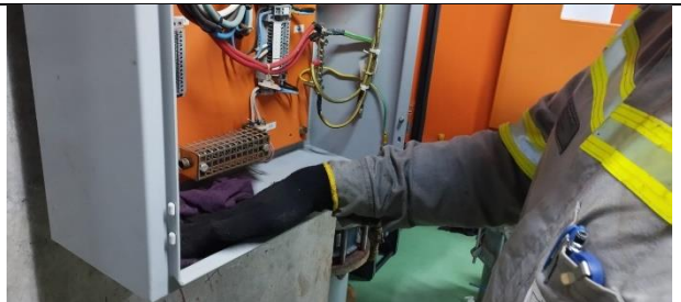
Figura 24: Feito limpeza do painel de distribuição de alimentação das bombas.
