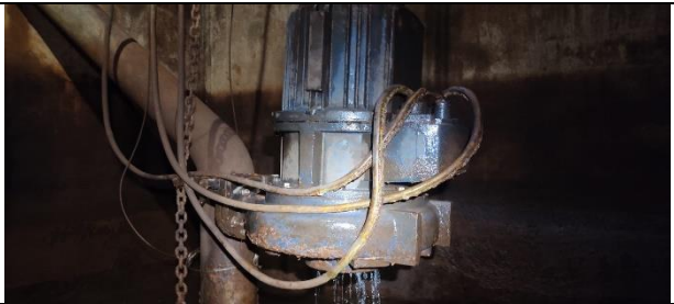
Figura 50: Inspeção realizada no poço, verificando estado de conservação das bombas no geral.
