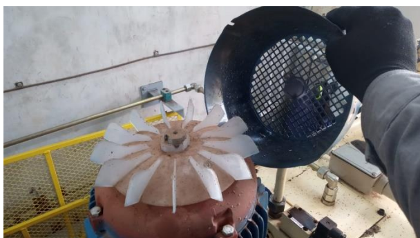
Realizada desmontagem das motobombas para limpeza.
