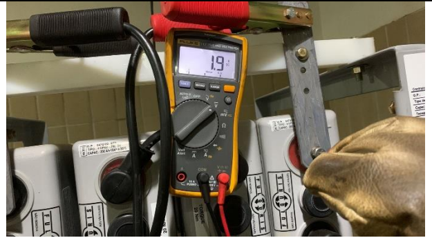
Figura 06 – Medição de tensão dos elementos ao realizar o descarregamento.
