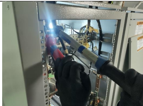
Figura 04: Realização de torqueamento dos pontos de conexão.
