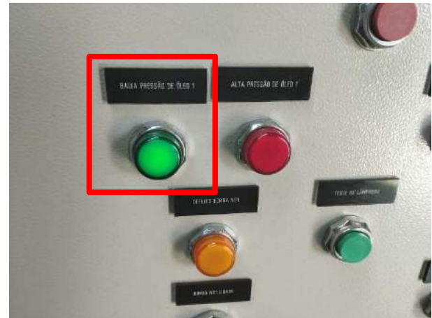
Figura 94 – Teste atuação baixa pressão VT – 3
