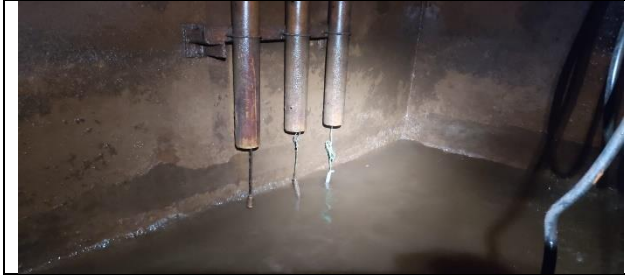
Figura 51: Inspeção realizada no poço, verificando estado de conservação de modo geral.
