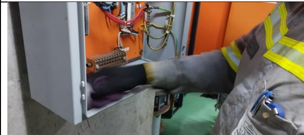
Figura 25: Feito limpeza do painel de distribuição de alimentação das bombas.
