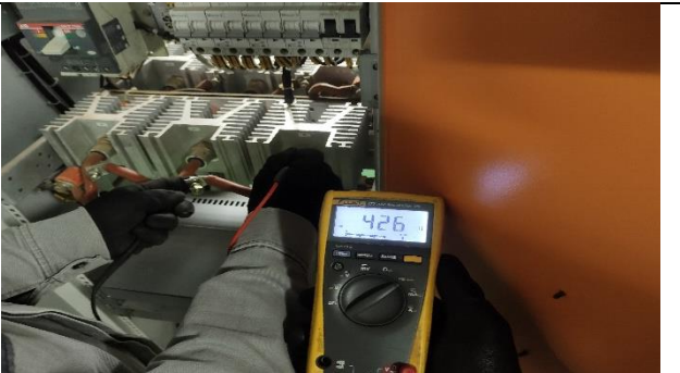
Figura 16: Feita medições dos diodos presentes no retificador.
