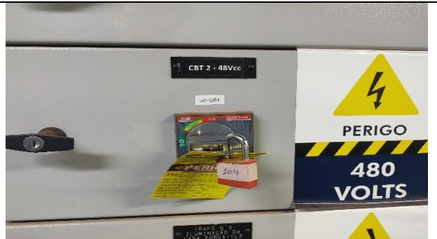
Figura 02: Realização de bloquei CBT1 48Vcc.
