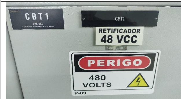
Figura 03: Realização de bloquei CBT1 48Vcc.
