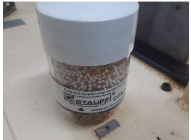
Figura 92 – Inspeção no filtro de aerção
