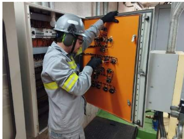
Figura 44 – Reaperto nas conexões dos quadros
