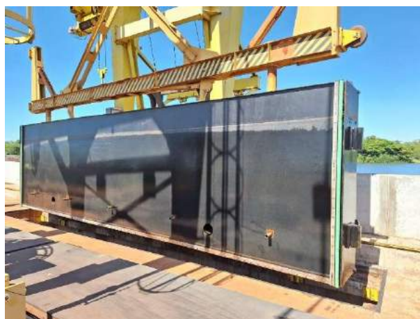
Figura 66 – Retirada ensecadeiras VT - 1
