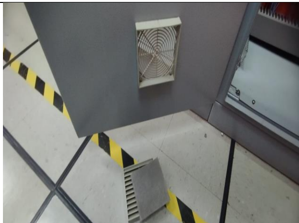
Figura 03 – Limpeza dos filtros de ar.
