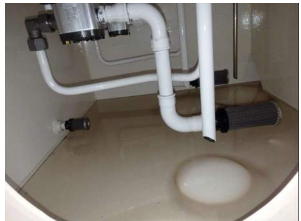
Figura 20 – Inspeção no estado das bombas de acionamento da comporta
