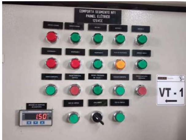
Figura 52 – Posição 1,5 m de abertura VT - 1
