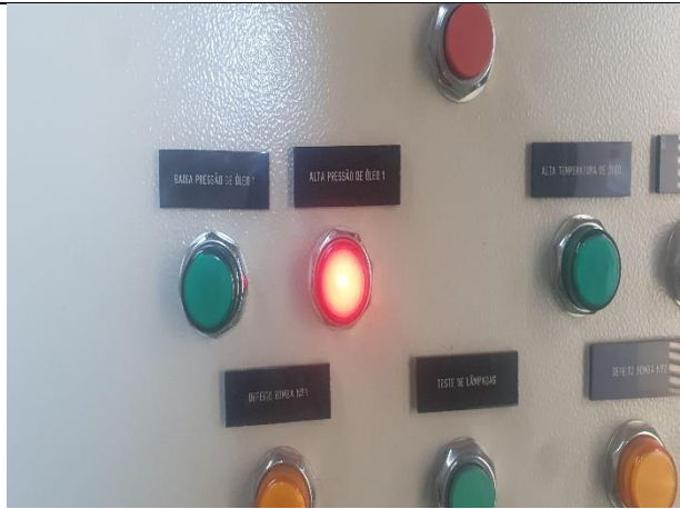
Figura 08 – Atuação de pressão alta na linha UHVT 1 / 2
