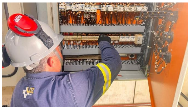
Reaperto nas conexões dos quadros
