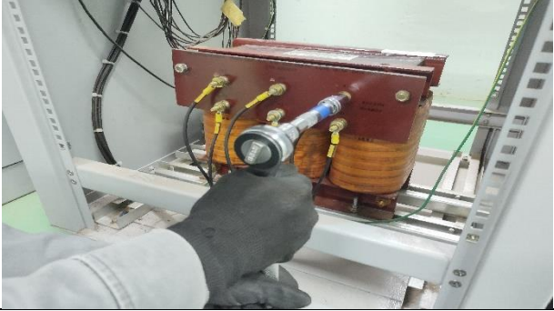
Figura 11: Realizado torque ideal de 15Nm nas conexões do Retificador 48Vcc.
