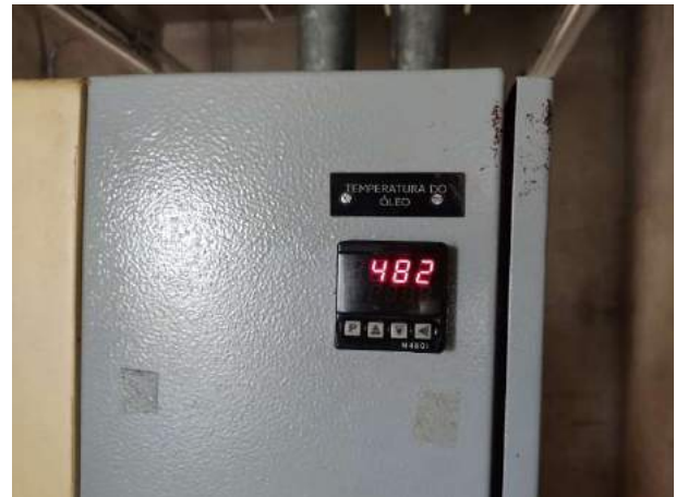
Figura 29 – Indicação de temperatura errônea
