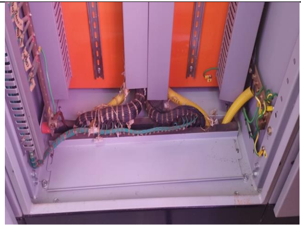
Figura 02 – Limpeza interna depois.
