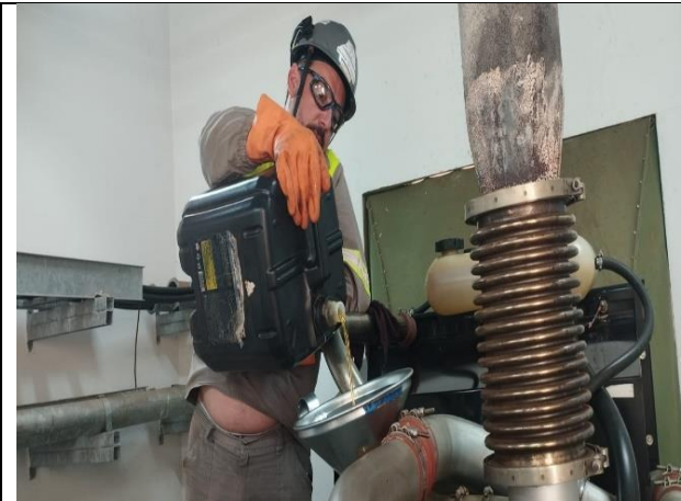
Figura 15 - Substituição do óleo diesel novo.
