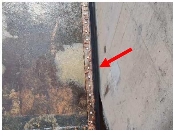
Figura 74 – Vedação em contato direto com o concreto
