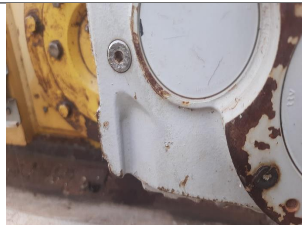
Inspeção no redutor de velocidade
