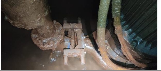
Figura 46: Inspeção realizada no poço, verificando estado de conservação das bombas no geral.
