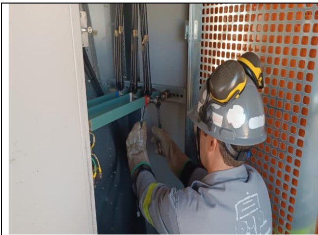
Figura 13 – Conferência de aperto nas conexões dos barramentos
