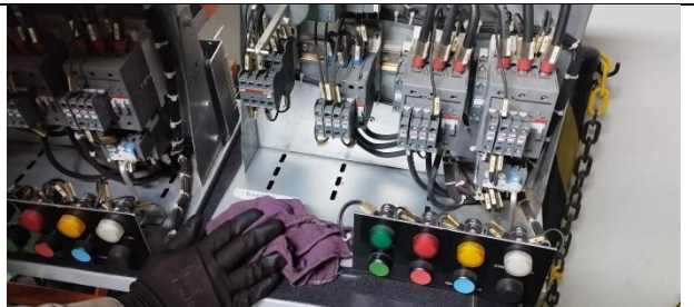
Figura 06: Feito limpeza nas gavetas das bombas.
