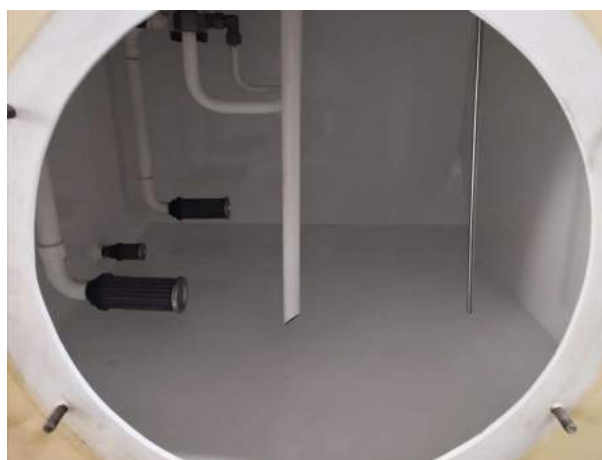
Figura 88 – Drenagem do óleo da central UHVT-03 e inspeção interna
