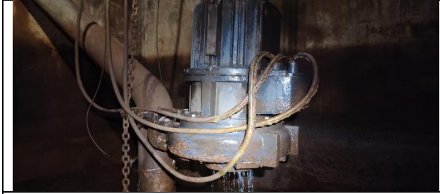
Figura 53: Inspeção realizada no poço, verificando estado de conservação das bombas no geral.
