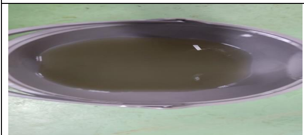
Figura 61: Óleo retirado da bomba para substituição.
