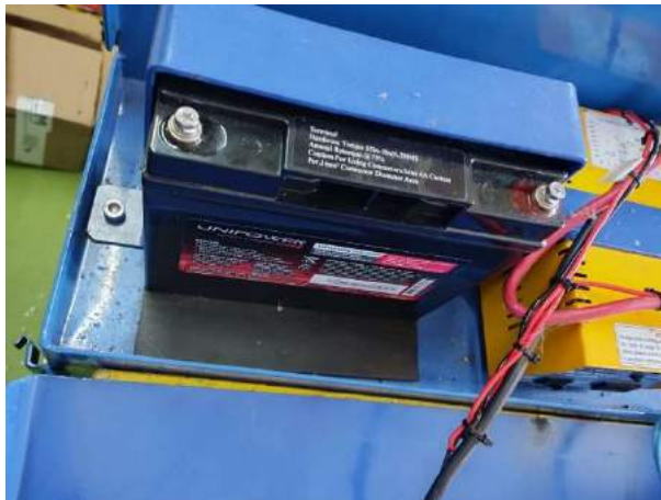
Figura 62 – Substituição da bateria da motobomba diesel UHVT-01-02
