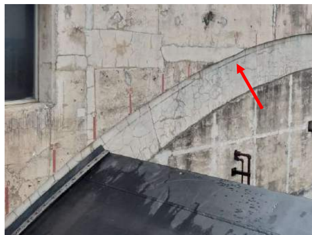
Figura 40 – Marca de desgaste da vedação por abrasão
