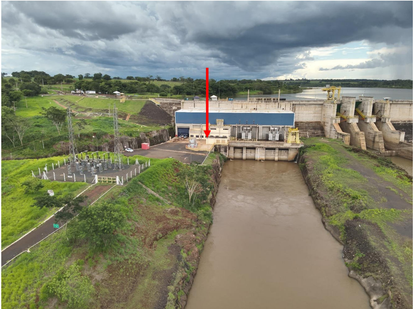
Foto Drone 02 - Imagem usina Caçu, 2024, vista jusante casa de força seta indicando a seção de instalação.
