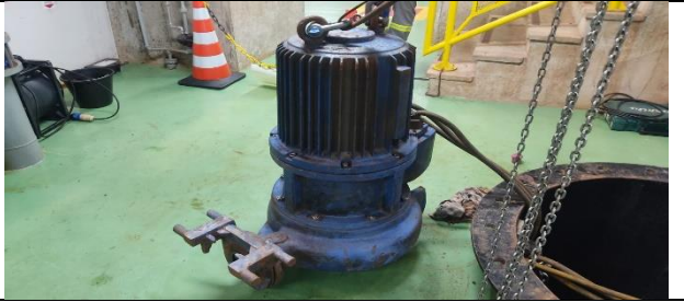
Figura 56: Bombas retiradas do poço.
