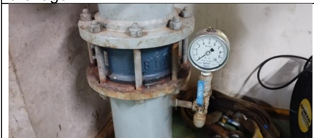
Figura 65: Verificação do estado de conservação dos manômetros da tubulação do poço de drenagem.
