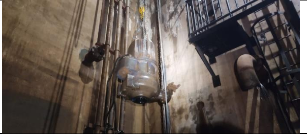
Figura 54: Inspeção realizada no poço, verificando estado de conservação das bombas no geral.
