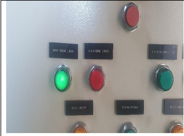
Figura 09 – Atuação de pressão baixa na linha UHVT 1 / 2
