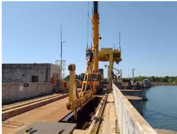
Figura 83 – Retirada ensecadeiras VT - 2
