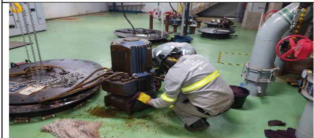
Figura 57: Realização de inspeção detalhada e limpeza.
