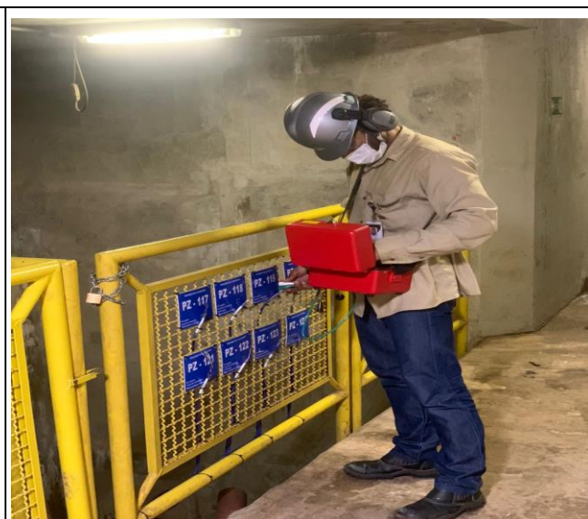
Foto 22 – Leitura após a instalação dos piezômetros elétricos.
