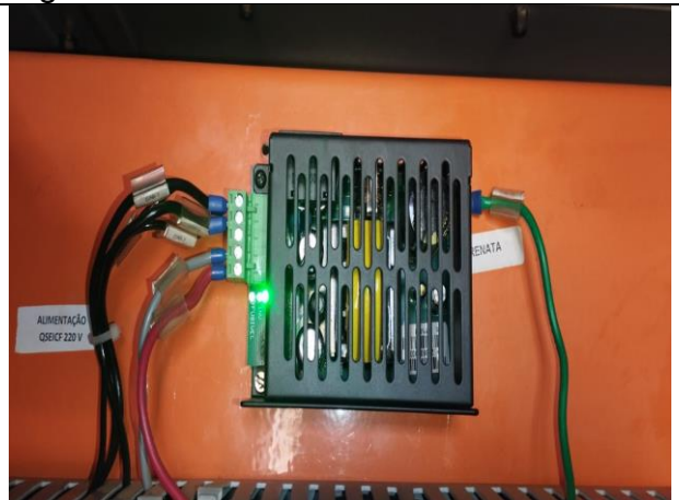
Figura 24 – Verificação da fonte
