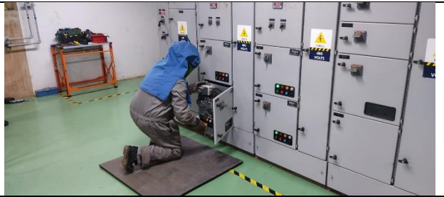
Figura 02: Realizado bloqueio das gavetas das bombas.
