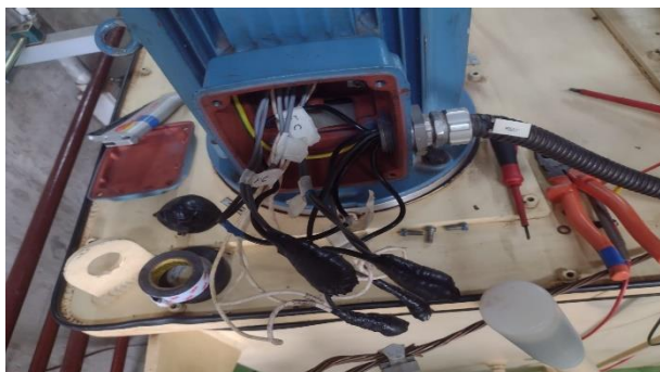
Verificações na motobomba 01 quanto ao estado e cabeamento
