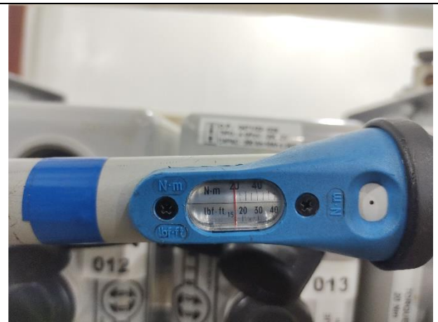
Figura 46 - Aplicação torque conforme manual do fabricante.
