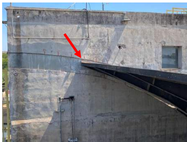
Figura 114 – Vedação lateral em contato direto com o concreto
