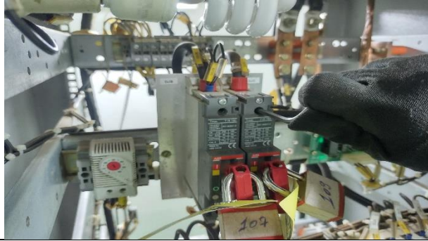
Figura 24: Realizado reaperto nos conectores do painel.
