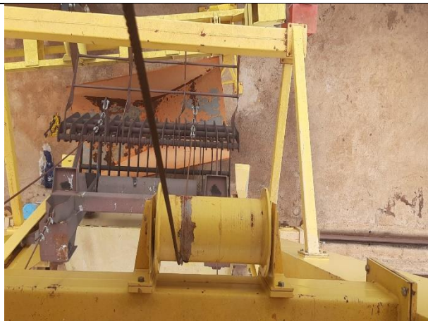
Inspeção na viga pescadora
