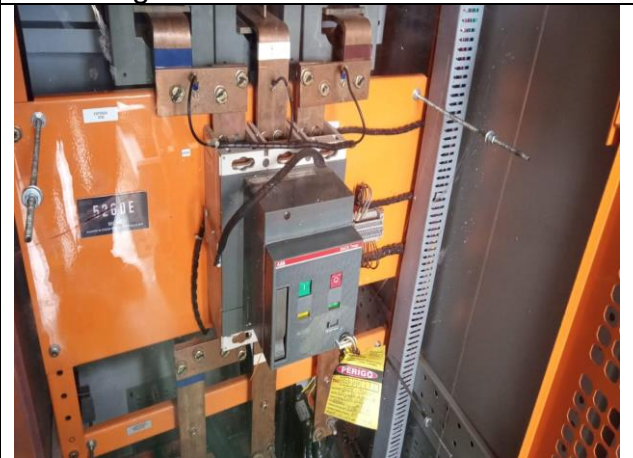
Figura 20 -Melhoria Instalação do acrílico
