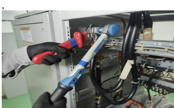
Figura 19: Realizado torque ideal de 15Nm nas conexões do Retificador 48Vcc.
