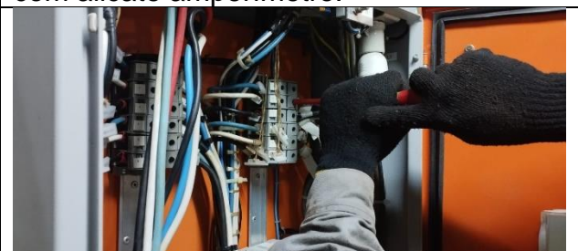
Figura 16: Realizado reaperto de componentes.
