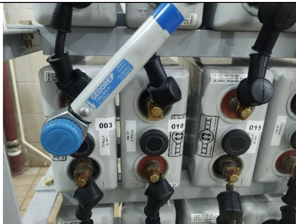
Figura 45 - Aplicação torque conforme manual do fabricante.
