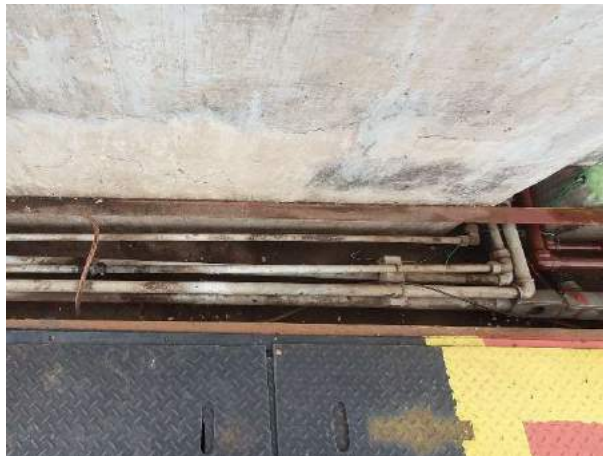
Figura 70 – Inspeção nas tubulações e conexões do VT - 2
