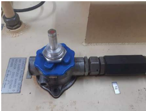
Figura 91 – Verificação do filtro de retorno
