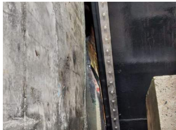
Figura 02 – Deslocamento da comporta 1 para direita
