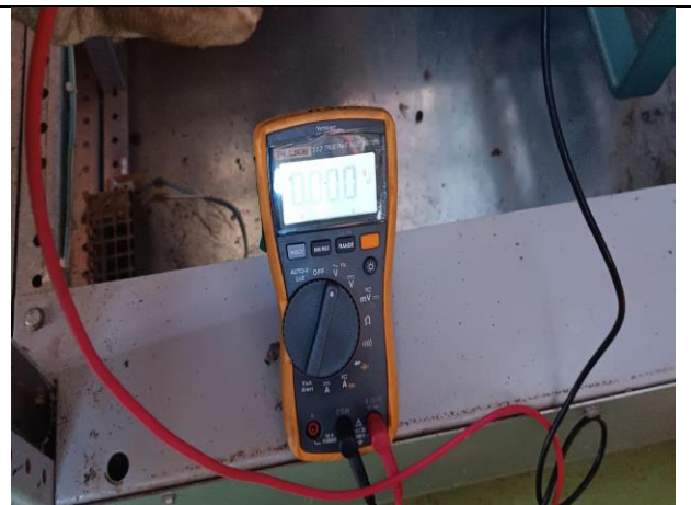
Figura 02 – Medição ausência de tensão
