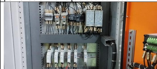
Figura 29: Inspeção visual nos componentes do painel de alimentação.
