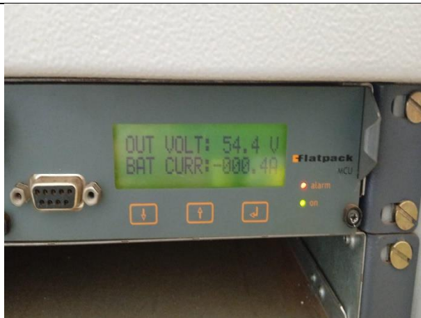
Figura 51 - Acompanhamento aplicação de carga pelo retificador.
