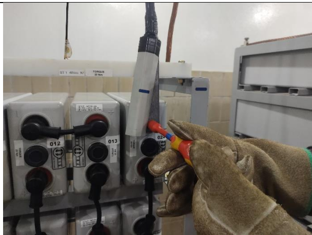
Figura 45 - Aplicação torque conforme manual do fabricante.
