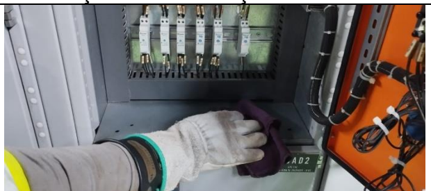
Figura 28: Feito limpeza do painel de alimentação das bombas.
