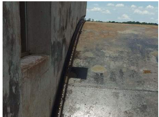
Figura 68 – Manobra de acionamento completa da comporta 02
