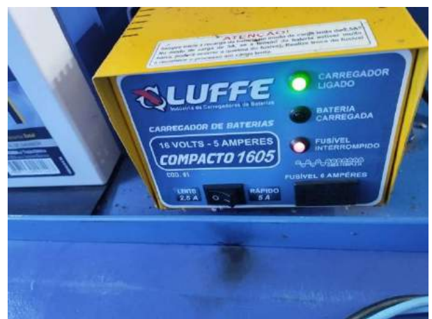
Figura 61 – Substituição do fusível do carregador da motobomba diesel UHVT-01-02
