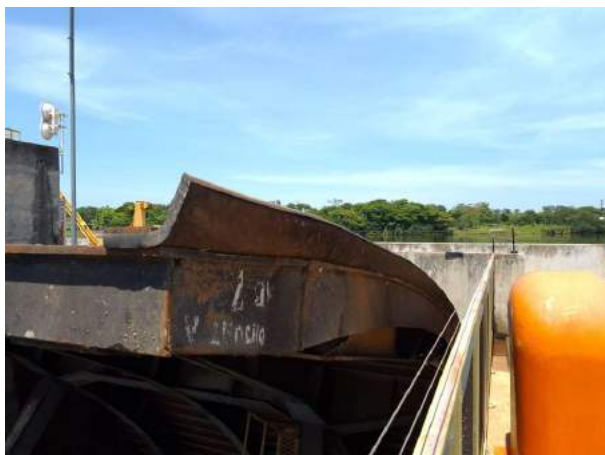
Figura 112 – Inspeção das vedações laterais da comporta VT - 3
