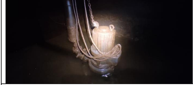
Figura 47: Inspeção realizada no poço, verificando estado de conservação das bombas no geral.
