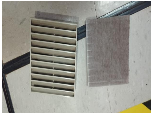
Figura 04 – Limpeza dos filtros de ar.
