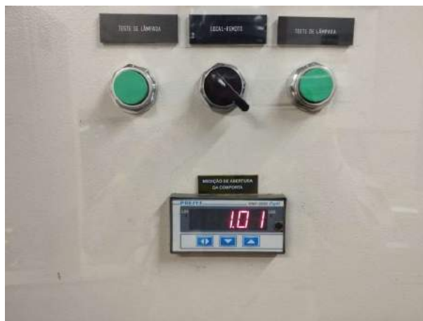
Figura 122 – Teste de estanqueidade VT - 3
