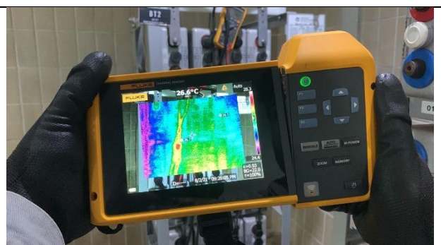
Figura 10 – Realizada medição de temperatura nos pontos de conexão das baterias ao realizar o carregamento.
