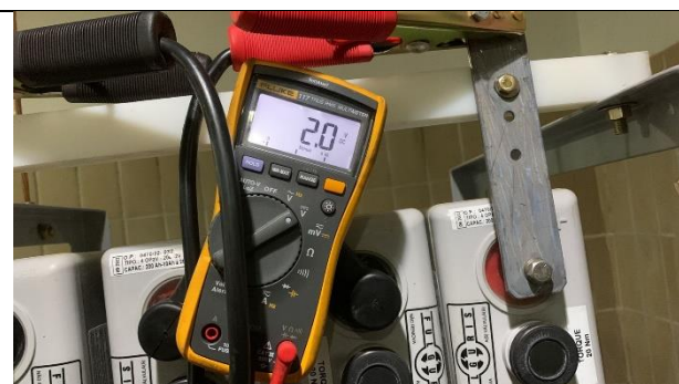
Figura 09 – Medição de tensão dos elementos ao realizar o carregamento.
