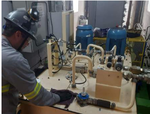
Figura 107 – Limpeza geral da central UHVT-03
