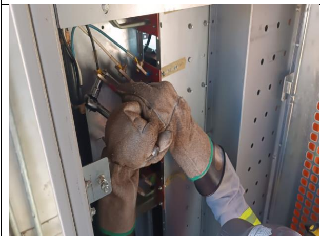
Figura 17 – Inspeção dos cabos e conferencia de reaperto
