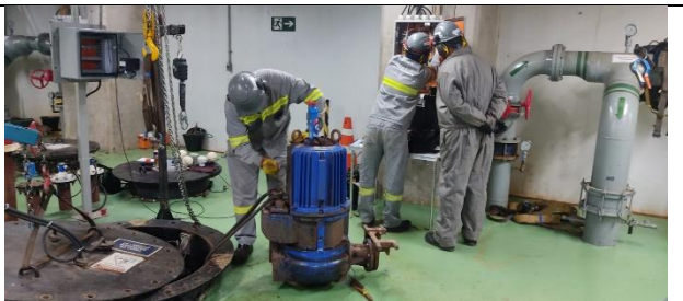
Figura 58: Realização de inspeção detalhada e limpeza.
