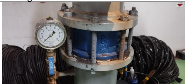
Figura 64: Verificação do estado de conservação dos manômetros da tubulação do poço de drenagem.
