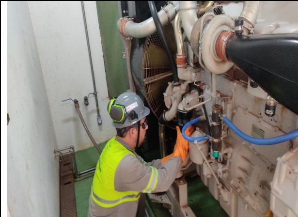
Figura 07 - Substituição Filtro óleo lubrificante.
