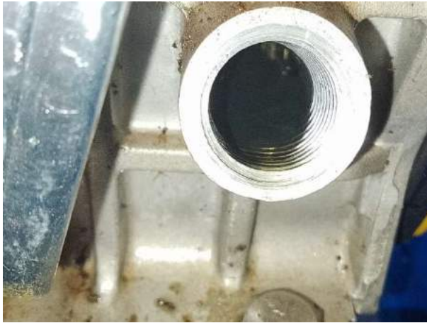
Figura 128 – Substituição do óleo lubrificante dos motores
