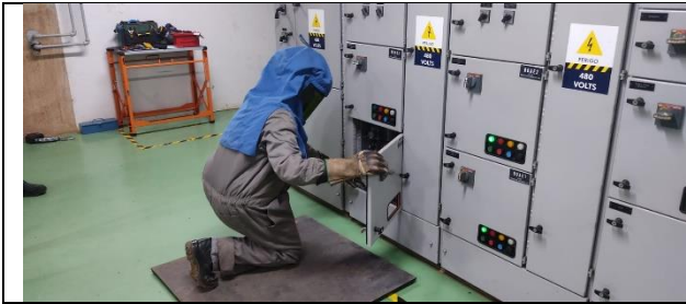
Figura 01: Realizado bloqueio das gavetas das bombas.
