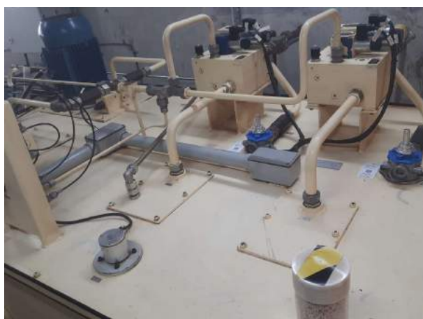
Figura 34 – Limpeza geral da central UHVT-01-02
