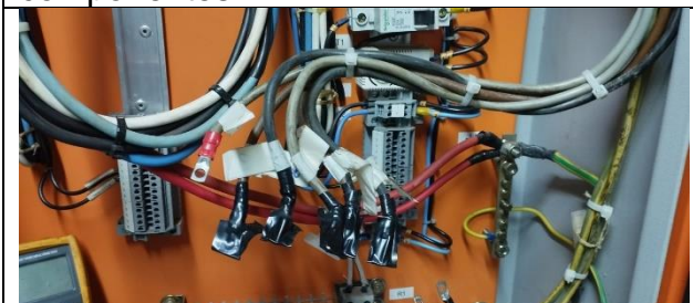
Figura 19: Realizado isolamento das pontas dos cabos para realizar ensaios.
