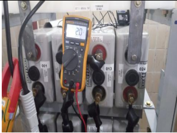
Figura 19 – Medição de tensão VPE do ciclo 2hs.
