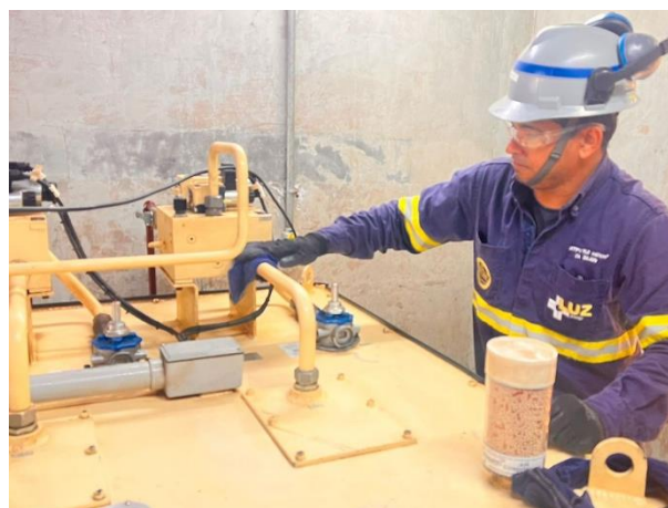
Limpeza geral da central hidráulica do VT3
