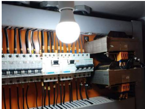
Figura 46 – Testes na iluminação interna dos quadros
