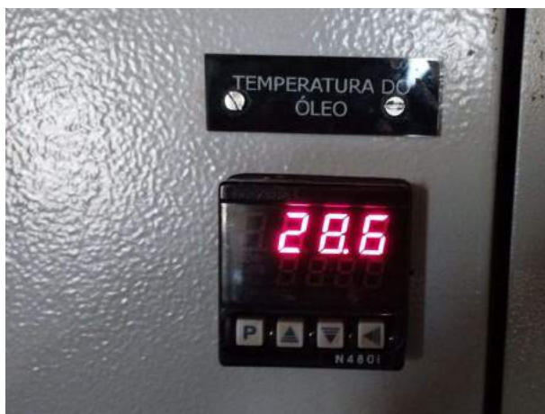
Figura 30 – Normalizado medição de temperatura da central UHVT-01-02
