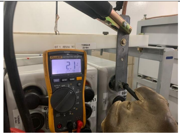
Figura 08 – Medições de tensão VPE banco de baterias repouso.
