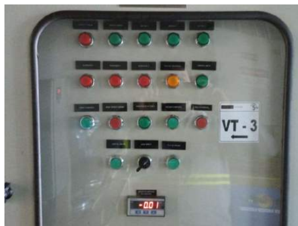
Figura 124 – Comporta VT – 3 fechada, com indicação de - 0,01m no Presys e sem status de fechada
