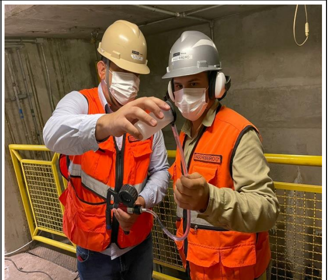
Foto 12 – Preparação da mangueira com água para injeção por pressão.
