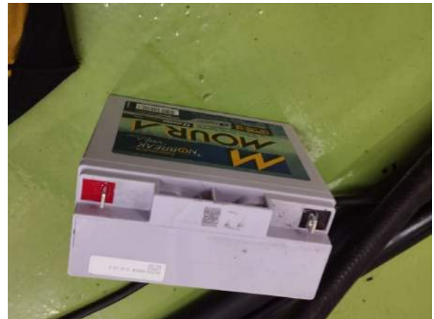
Figura 63 – Substituição da bateria da motobomba diesel UHVT-01-02
