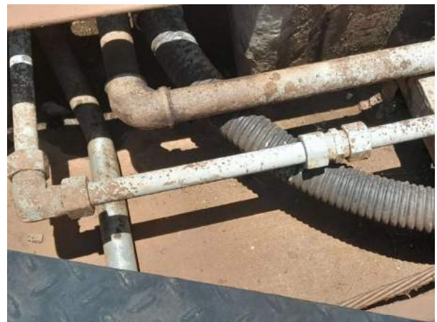
Figura 109 – Inspeção nas tubulações e conexões do VT - 3
