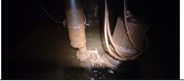
Figura 48: Inspeção realizada no poço, verificando estado de conservação das bombas no geral.
