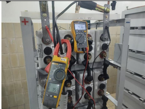
Figura 27 – Medições de tensão e corrente do ciclo 5hs..
