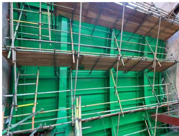
Figura 38 – Pintura da comporta 01
