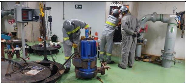
Figura 58: Realização de inspeção detalhada e limpeza.
