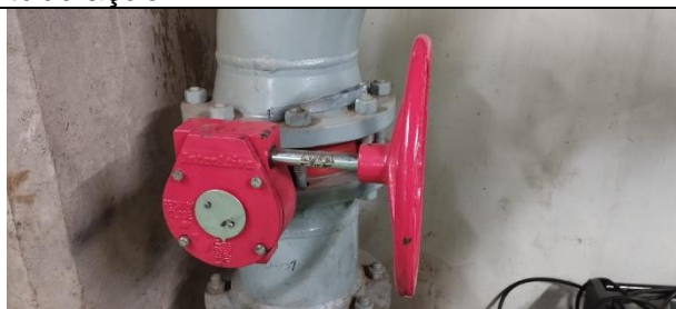
Figura 62: Verificação de funcionamento das válvulas da tubulação do poço de drenagem.
