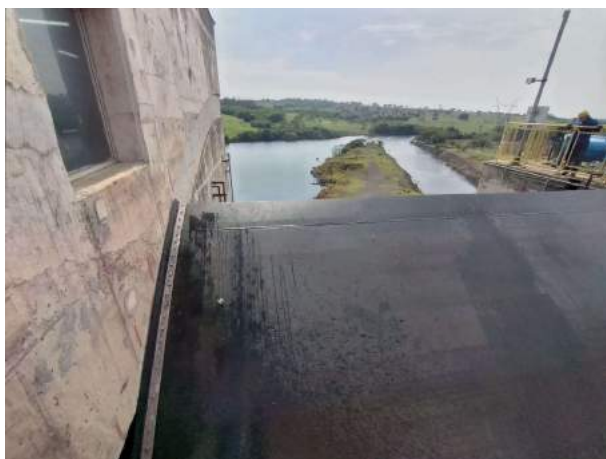
Figura 39 – Vedação em contato direto com o concreto
