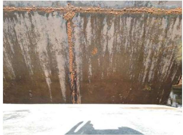
Figura 73 – Oxidações nas soldas da comporta
