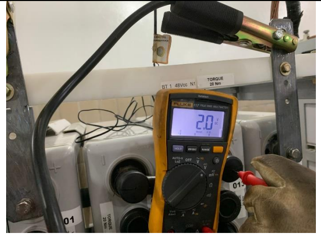
Figura 14 – Medição de tensão VPE ciclo 15 minutos.
