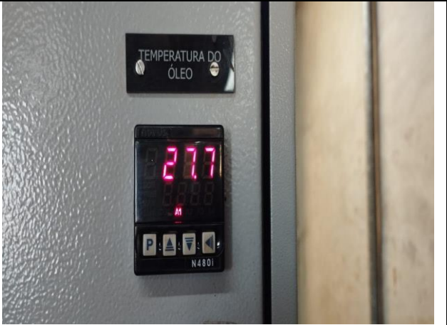
Figura 07 – Atuação de alta temperatura de óleo UHVT 1 / 2
