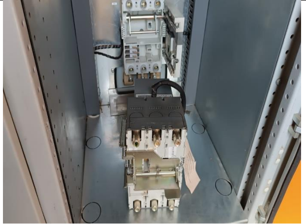
Figura 24 – Inspeção do disjuntor e sistema de extração
