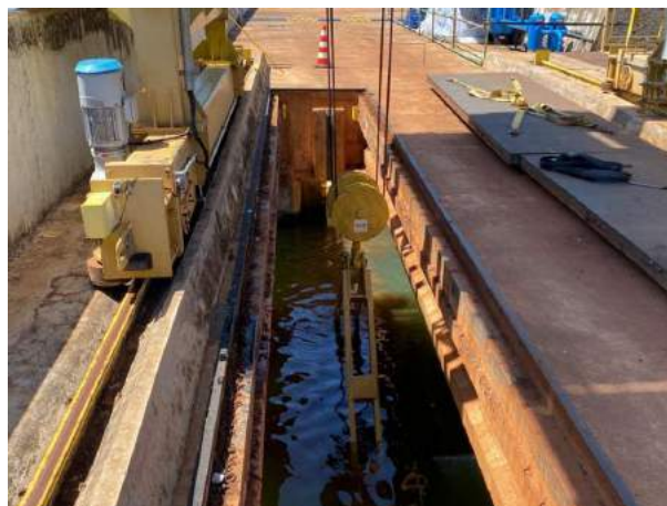
Figura 132 – Retirada ensecadeiras VT - 3
