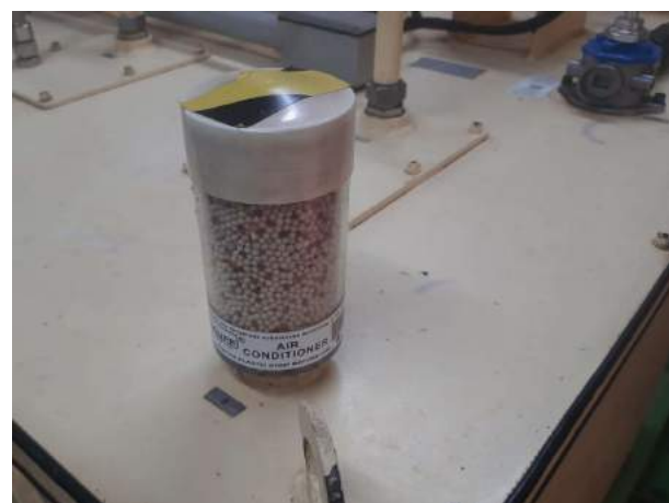
Figura 14 – Inspeção no filtro de aeração
