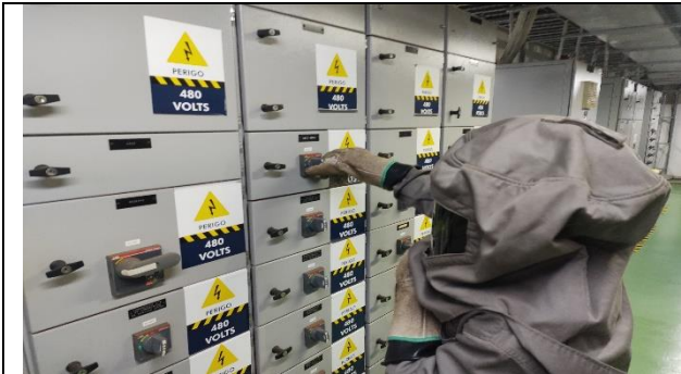
Figura 01: Realização de bloqueios
