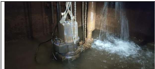
Figura 41: Inspeção realizada no poço, verificando estado de conservação das bombas no geral.
