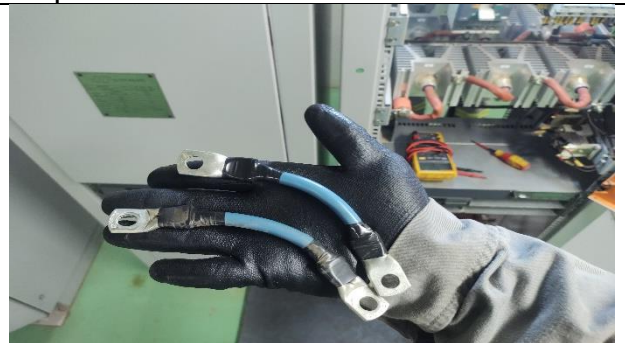
Figura 31: Cabos retirados dos retificadores após a manutenção geral do equipamento.
