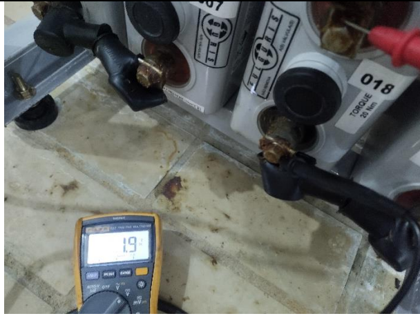
Figura 37 – Medição de tensão VPE do ciclo 8hs.
