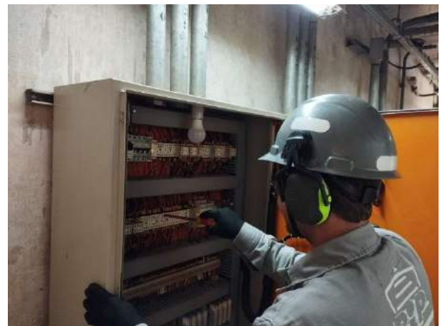
Figura 117 – Reaperto nas conexões e bornes dos quadros VT - 3
