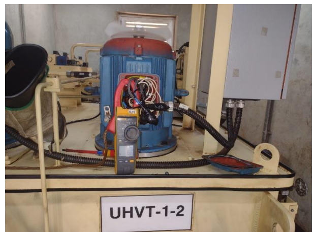
Verificação das conexões dos motores
