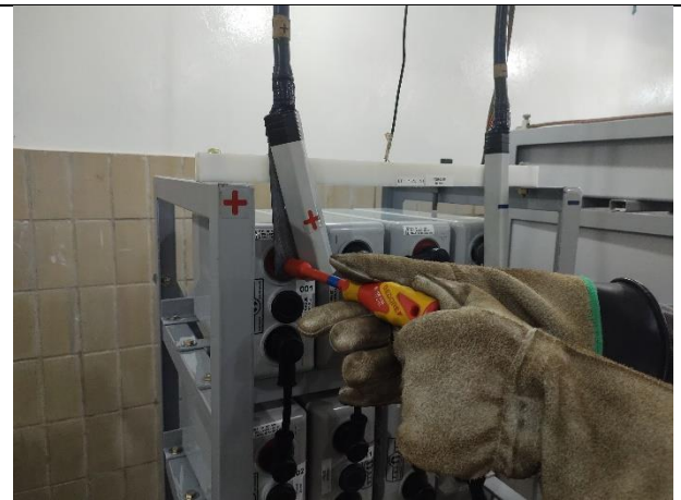
Figura 46 - Aplicação torque conforme manual do fabricante.
