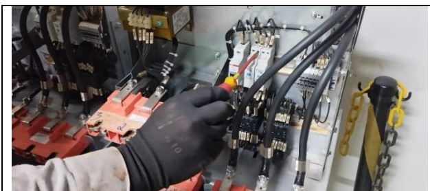
Figura 11: Realizado reaperto das conexões das gavetas.
