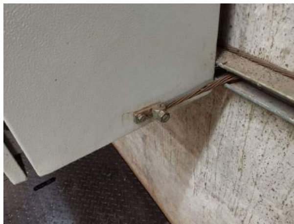
Figura 22 – Inspeção no estado dos aterramentos dos quadros
