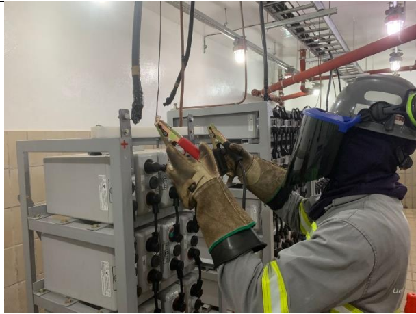
Figura 09 – Conexão dos cabos positivo e negativo descarregador
