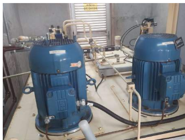
Figura 35 – Limpeza geral da central UHVT-01-02
