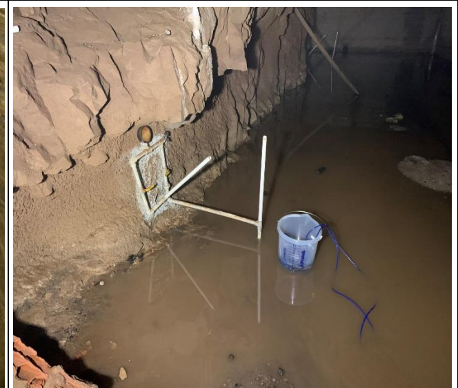
Foto 16 – Leitura fora do preservativo, antes da instalação.
