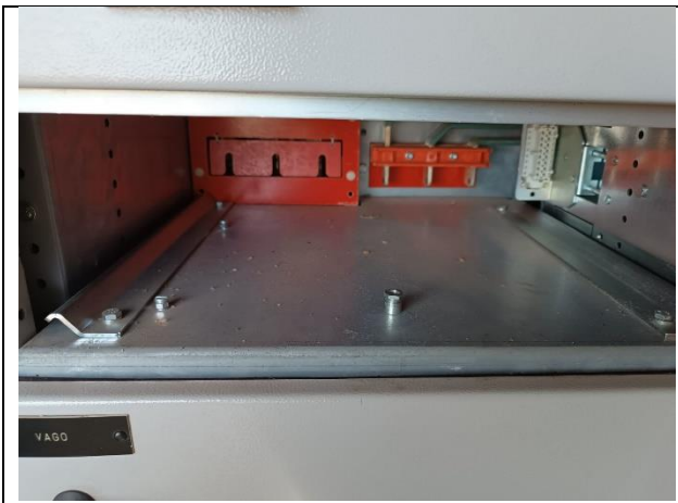
Figura 05 – Inspeção nicho das gavetas
