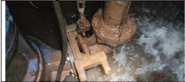
Figura 43: Inspeção realizada no poço, verificando estado de conservação das bombas no geral.
