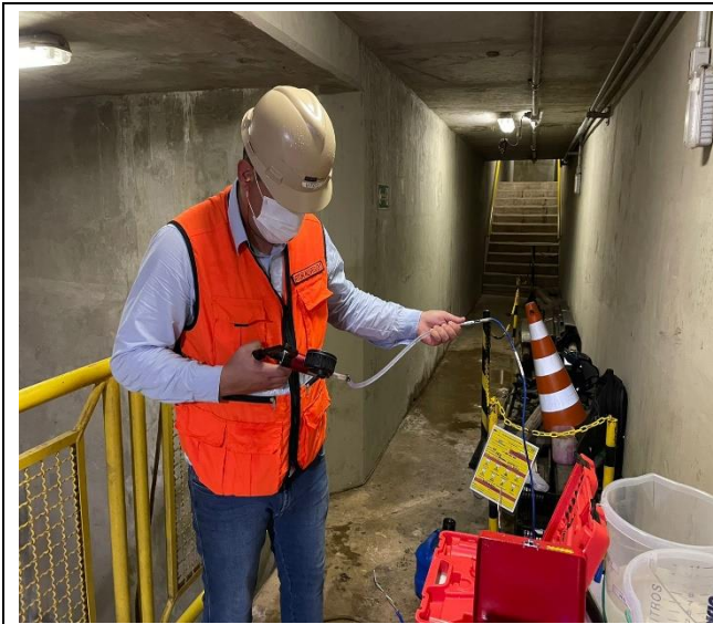
Foto 13 – Saturação da pedra porosa por injeção d'água com pressão.
