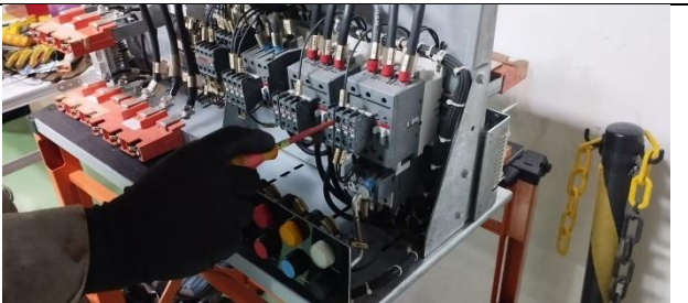
Figura 10: Realizado reaperto das conexões das gavetas.
