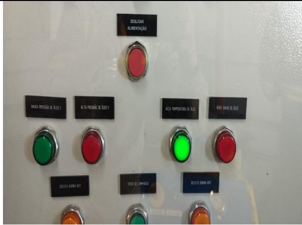
Figura 06 – Atuação de alta temperatura de óleo UHVT 1 / 2
