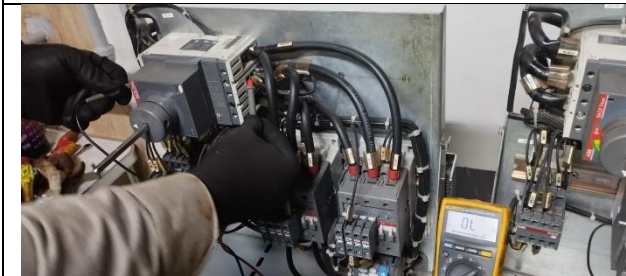
Figura 05: Feito reaperto nas conexões do DJ da gaveta.
