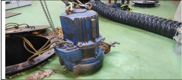
Figura 55: Bombas retiradas do poço.
