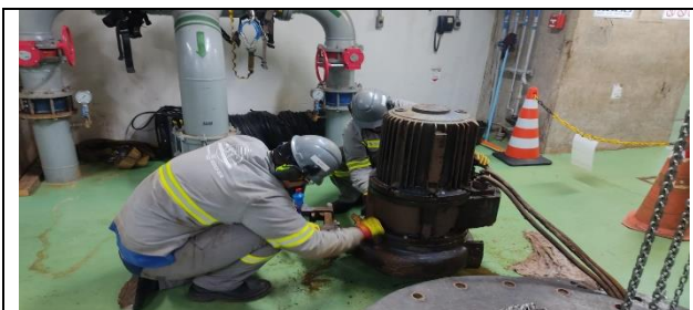
Figura 59: Realização de inspeção detalhada e limpeza.
