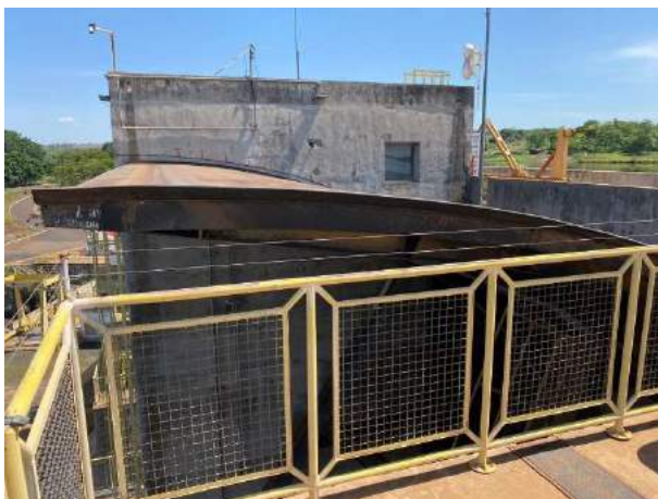
Figura 110 – Inspeção das vedações da comporta e estruturas
