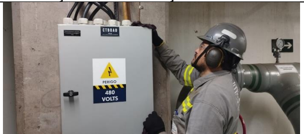
Figura 26: Feito limpeza do painel de distribuição de alimentação das bombas.
