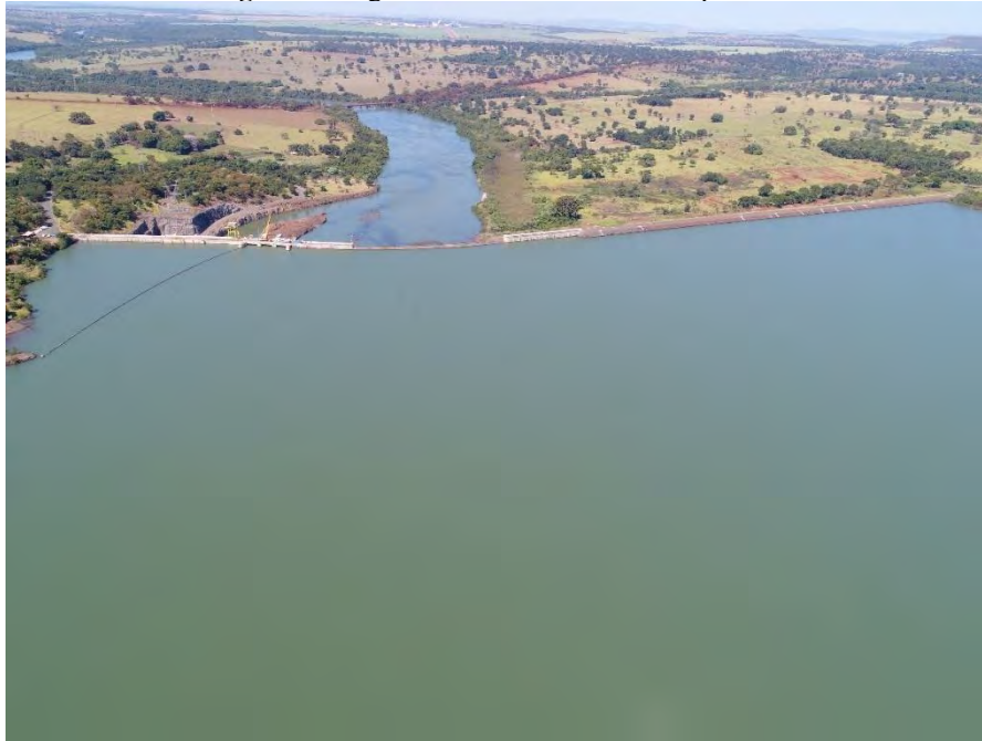
Figura 2: Log Boom UHE Barra dos Coqueiros.
