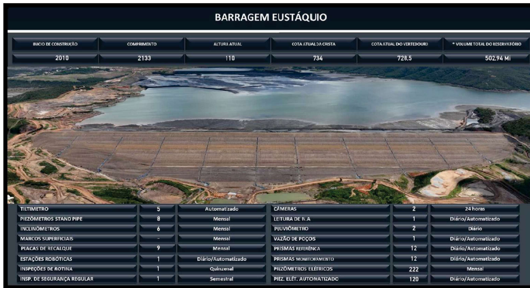
Figura 15 - Monitoramento e Instrumentação Estrutura de Disposição de Rejeitos Eustáquio - Barragem Eustáquio.
